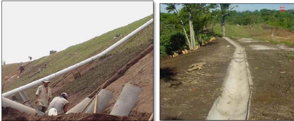
Ilustración 14 -Construcción de cunetas en bermas y en la corona de un talud, utilizando elementos prefabricados de concreto
