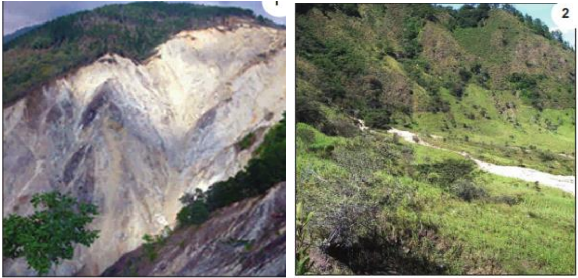
Ilustración 33- Deslizamiento traslacional en suelo. Cárcava de la Zomopera, Bella Vista La Palma, Chalatenango.
