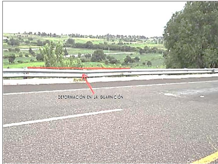
Ilustración 18- Deformación de Guarnición.
