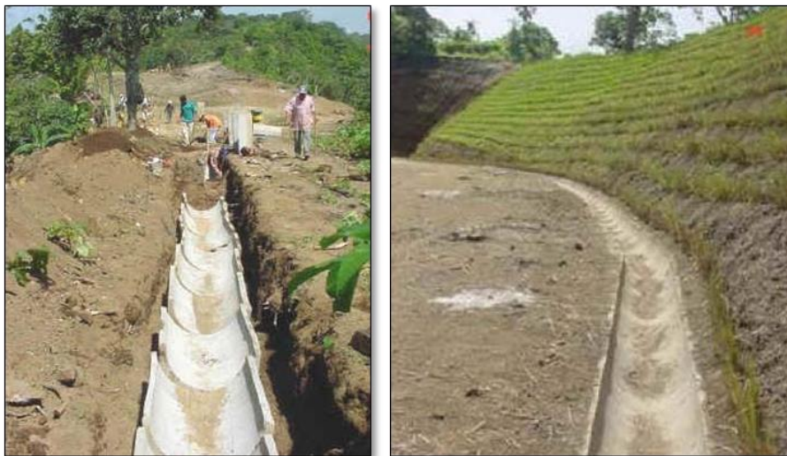
Ilustración 14 -Construcción de cunetas en bermas y en la corona de un talud, utilizando elementos prefabricados de concreto
