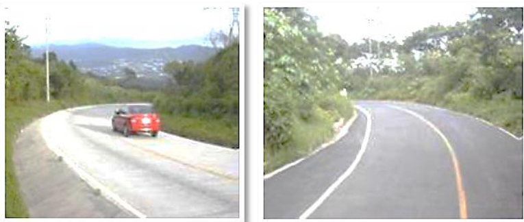
Ilustración 24- Carretera Longitudinal del Norte (secundaria) y red de caminos rurales (terciaria)
