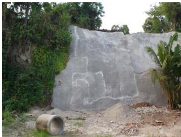
Ilustración 17- Revestimiento de mortero para la estabilización de un talud ubicado en Santo Tomás, sobre la Carretera Panamericana.
