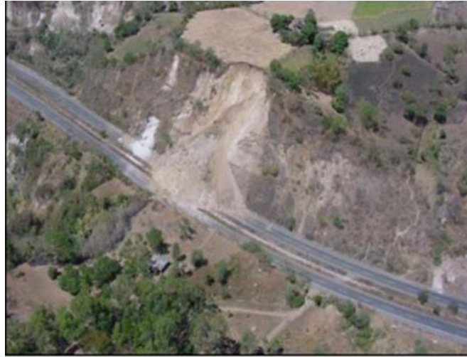
Ilustración 10 -Talud N°2, ubicado en Carretera Panamericana, Km 5+340 – 5+420
