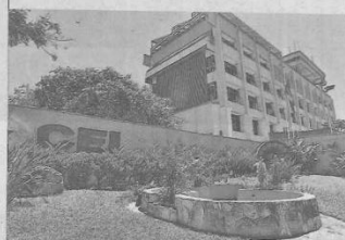
Carga financiera. El subsidio a la energía se paga con fondos de la CEL. Esta ha acumulado una deuda de $53 millones con las distribuidoras.
