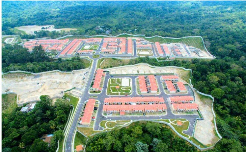
Imagen no. 2. Vista aérea de la zona donde se llevó a cabo la construcción de la Residencial Sierra Verde.
