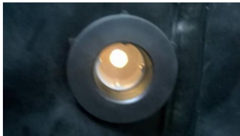
Figura A- 7. Vista interna del desagüe del estanque
