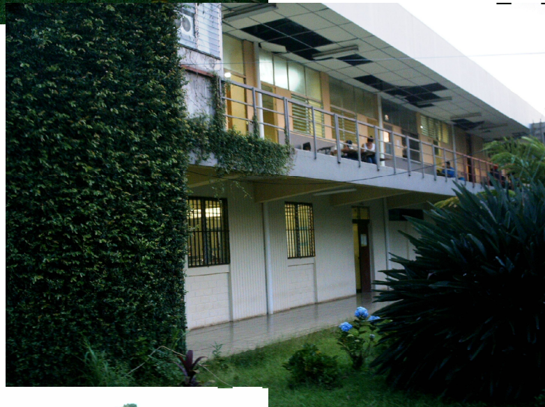
Fig. 3.20 Edificio Ex - Biblioteca
