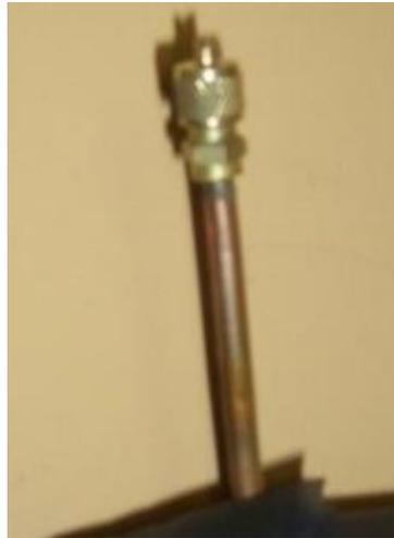
**Figura 57.** Válvula de servicio instalada en el lado de baja presión.
