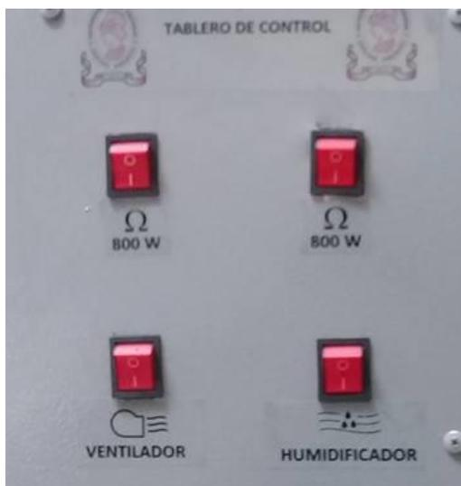
**Figura 102.** Tablero de control con interruptores apagados.
