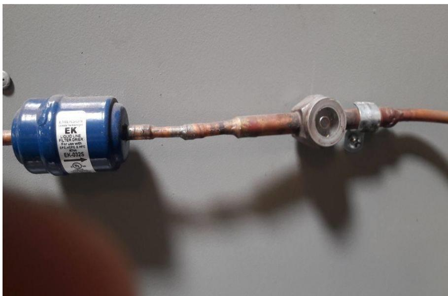
**Figura 56.** Filtro + visor + abrazadera.
