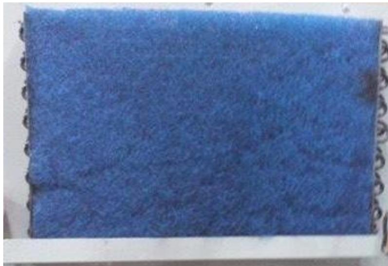
**Figura 54.** Filtro protector del condensador.
