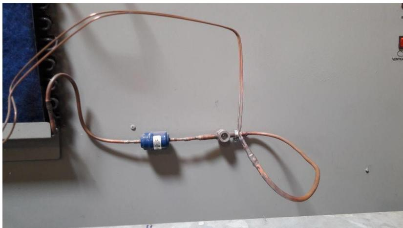
**Figura 55.** Capilar instalado.
