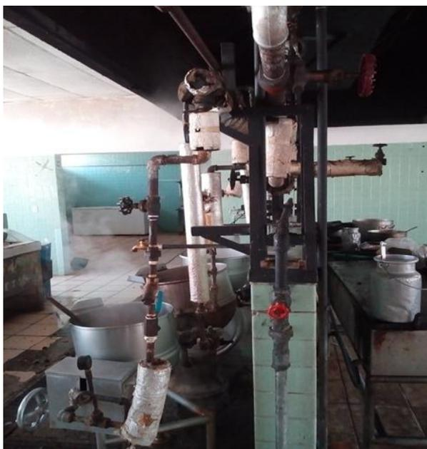
**Imagen 3.43: Válvulas y tuberías de vapor en área de cocina.**
