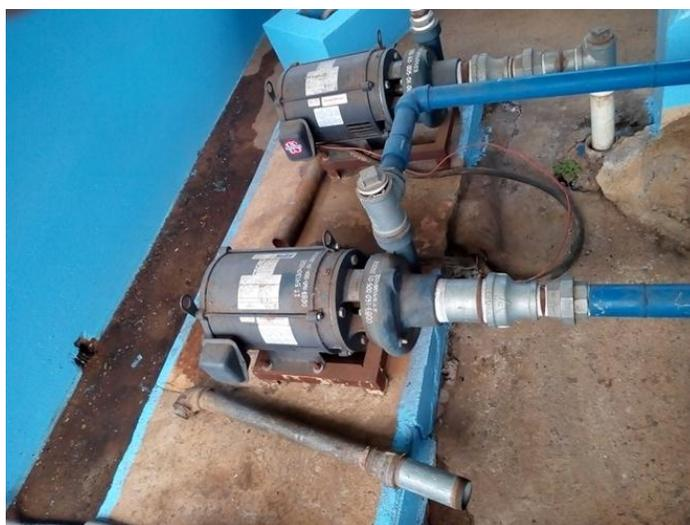
**Imagen 3.30: Bombas del sistema de emergencia colocadas sobre cisterna.**
