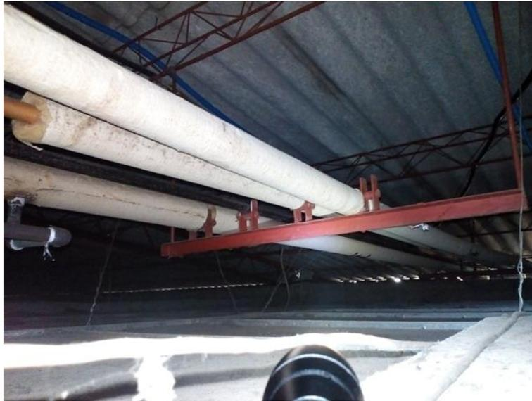
**Imagen 3.42: Tuberías de vapor aéreas, en pasillo central.**
