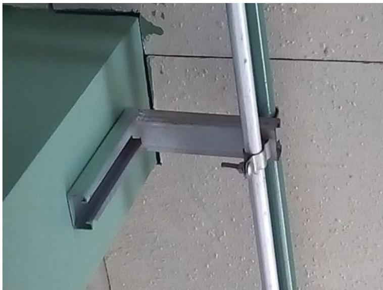
**Imagen 3.40: Anclaje de redes de tuberías de distribución de oxígeno.**
