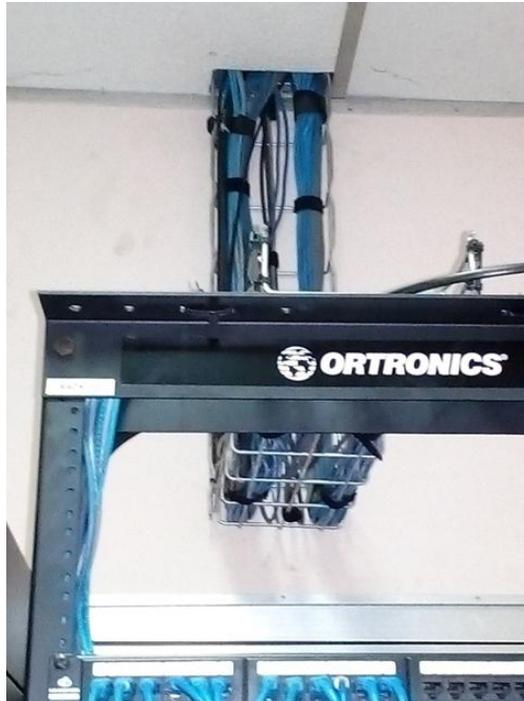
**Imagen 3.18: Cables del sistema de redes del hospital canalizados adecuadamente.**
