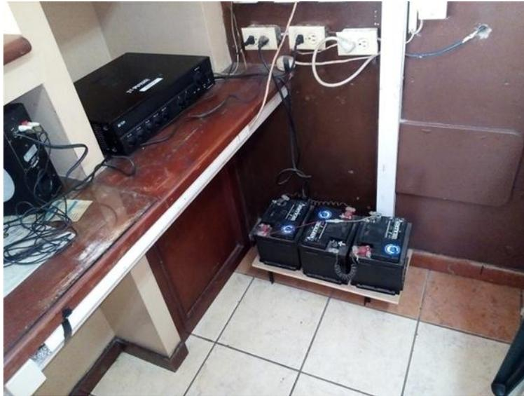
**Imagen 3.22: Parte del sistema de voceo y baterías de la central telefónica, ubicados en el área de recepción.**
