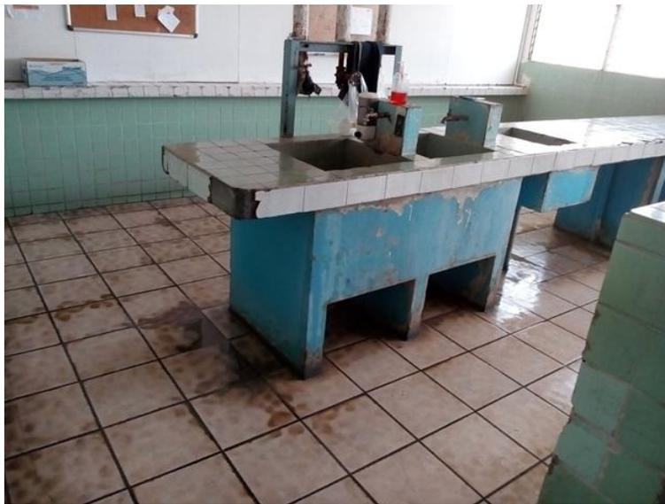
**Imagen 3.76: Piso deteriorado en área de cocina.**
