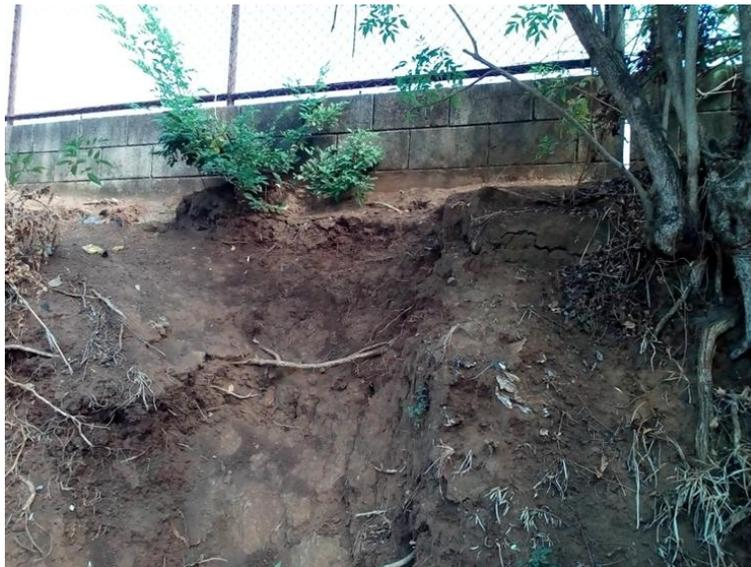
**Imagen 3.69: Posible riesgo de desprendimiento de tierra en terraplén exterior costado sur.**
