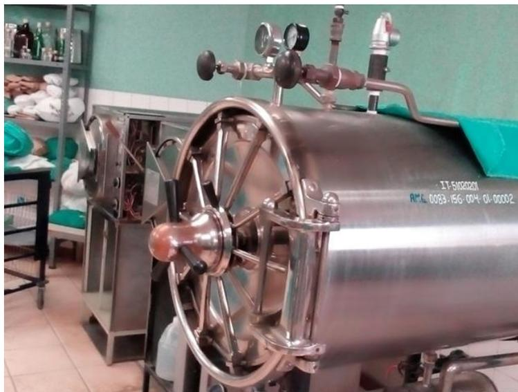
**Imagen 3.50: Autoclave o equipo de esterilización ubicado en arsenal.**
