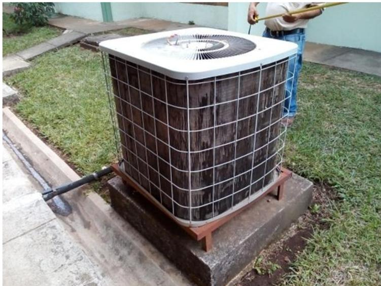
**Imagen 3.48: Compresor de aire acondicionado tipo Split ubicado en el exterior.**
