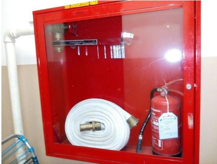
**Imagen 3.75: Hidrante y extintor situado en laboratorio.**
