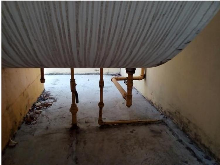
**Imagen 3.35: Tuberías de extracción de diesel.**
