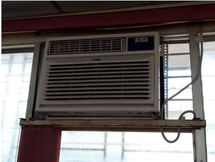
**Imagen 3.47: Aire acondicionado tipo ventana en área de laboratorio.**
