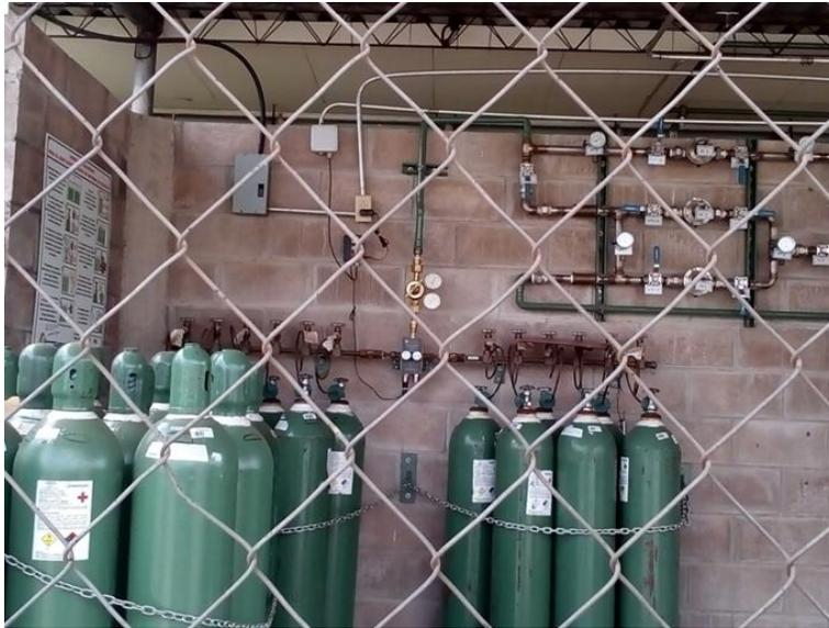
**Imagen 3.39: Sistema de emergencia de tanques de oxígeno móviles.**
