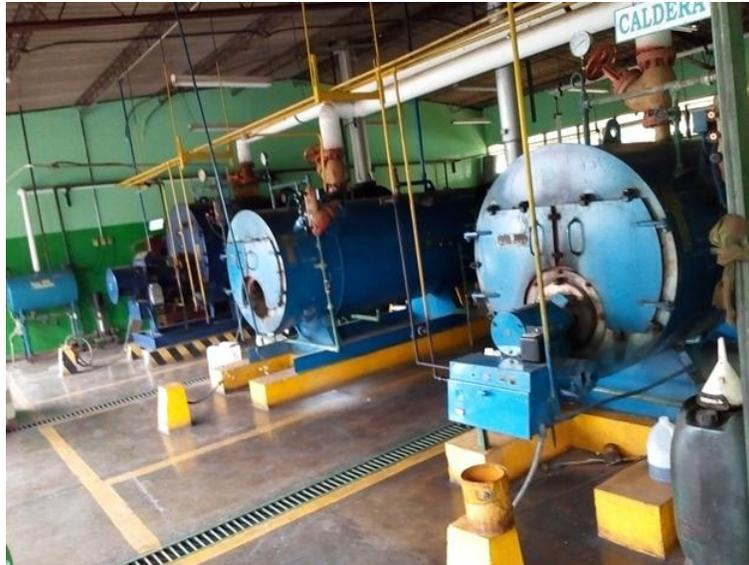
**Imagen 3.49: Recinto de calderas, calentador y generador eléctrico.**
