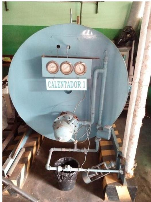
**Imagen 3.45: Calentador de agua anclado en área de calderas.**
