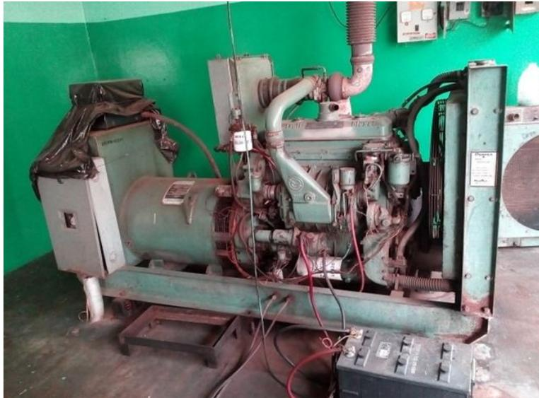
**Imagen 3.10: Generador 1 modelo Magna One, ubicado en el área de calderas.**
