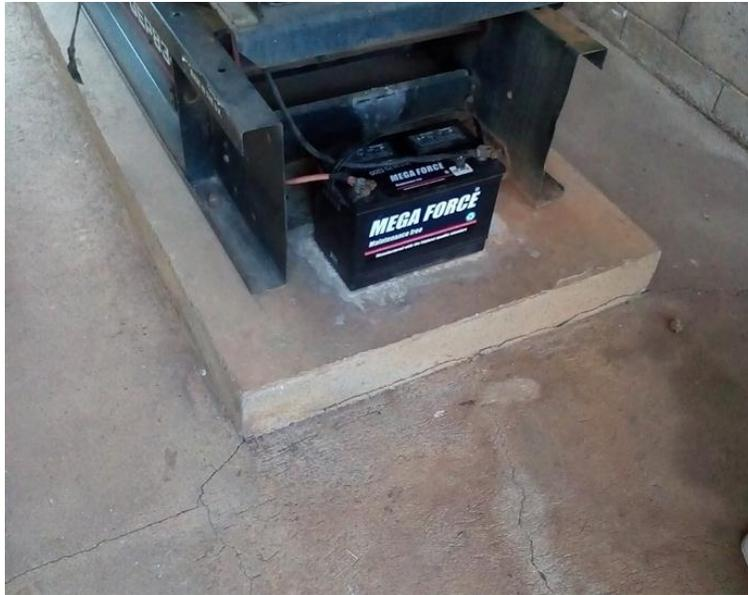
**Imagen 3.12: Generador 2 montado sobre losa de concreto, debido a escorrentía en época de lluvia, en la imagen también se observa la batería del generador.**
