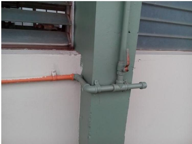
**Imagen 3.36: Tuberías y válvulas de control de suministro de gas propano.**
