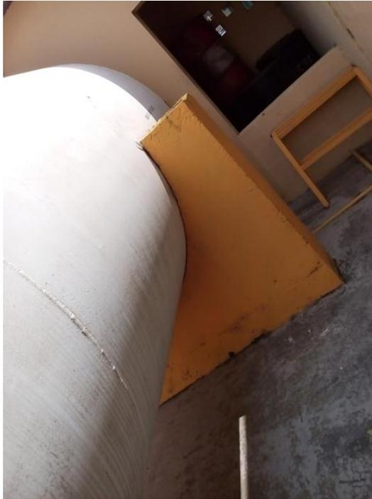
**Imagen 3.32: Anclaje de depósito de 5255 galones de Diesel.**
