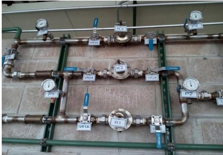
**Imagen 3.38: Tuberías y válvulas del sistema de distribución de oxígeno del hospital.**
