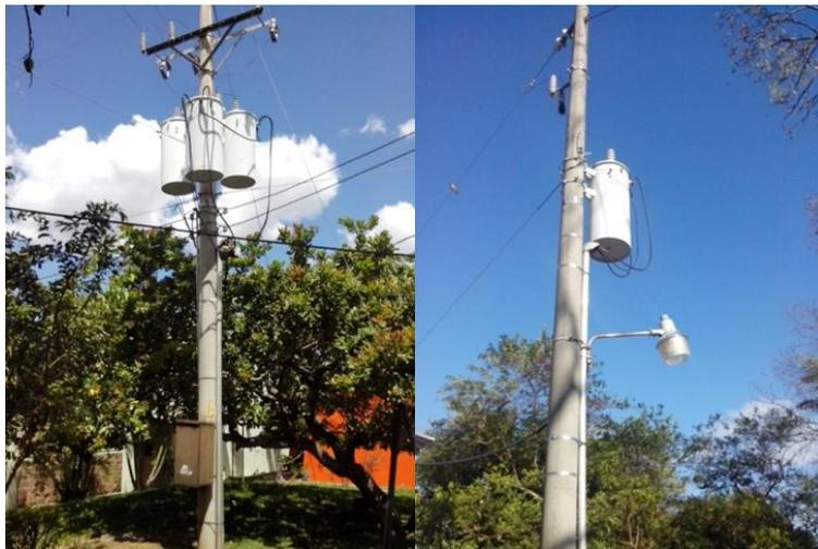
**Imagen 3.17: 2 Acometidas eléctricas, ubicadas frente al edificio de SIBASI, y a un costado de consulta externa; el hospital cuenta con tres acometidas eléctricas aparte de la sub-estación dentro de sus instalaciones.**
