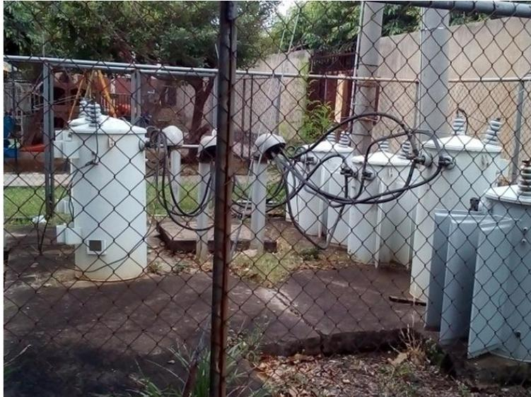
**Imagen 3.16: Sub-estacion eléctrica debidamente cercada y ubicada en area restringida.**
