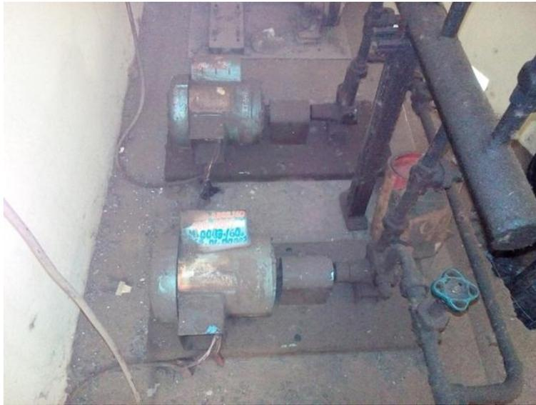
**Imagen 3.34: Bombas para extracción automática de diesel del depósito, ubicadas a un costado del depósito.**
