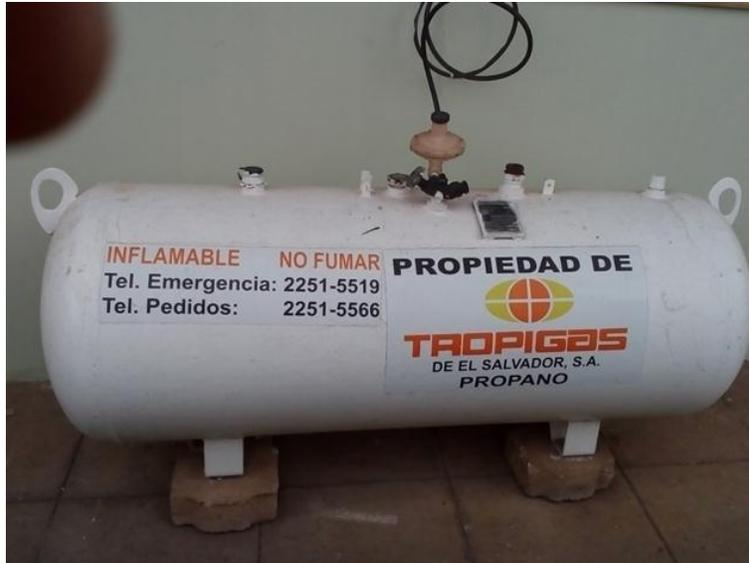
**Imagen 3.33: Depósito de gas propano al costado norte del are de cocina, sin anclaje.**
