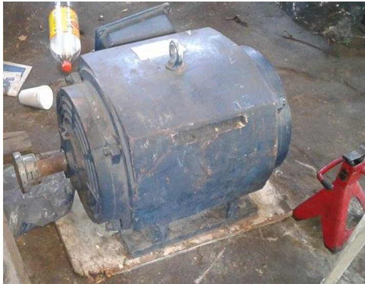
A.C.6. Fotografía de uno de los motores en reparación. Se puede observar las condiciones de suciedad que se tienen en la zona de trabajo del taller.
