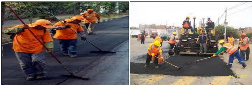
Figura 5.2 Proceso de colocación de carpeta asfáltica Fuente: http://www.elsalvador.com
