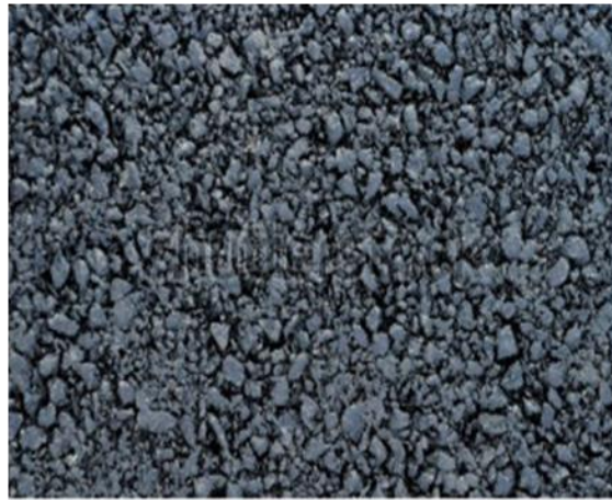
Figura 4.4 Ejemplo de Macrotextura de un pavimento
