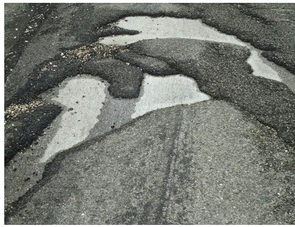
Figura 3.3 Corrimiento, FUENTE SIECA Manual Centroamérica de Mantenimiento de Carreteras TOMO III. Pág. 17.
