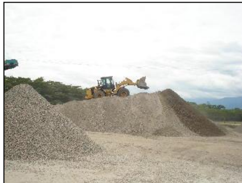
Figura. 2.2 Explotación del agregado, Fuente: Presentación de los autores
