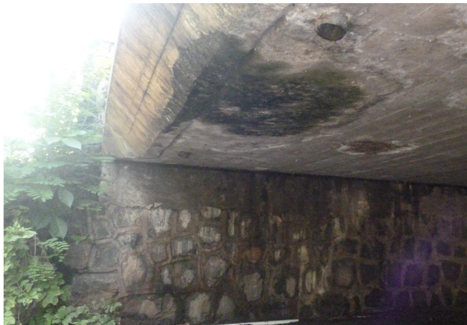
ANEXO 2. Fotografía 2 Puente Conchaliíto.
