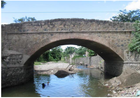
Figura 2.19. Puente de Mampostería.
