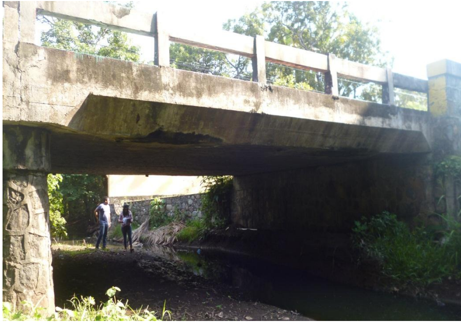
ANEXO 3. Fotografía 3 Puente Conchaliíto.
