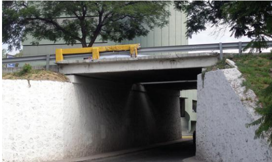
Figura 2.25. Puente de Losa de Concreto Presforzado.
