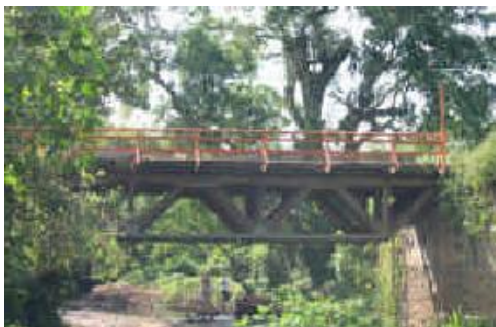
Figura 2.18. Puente de Madera
