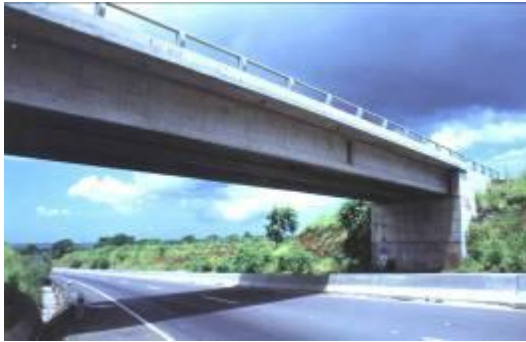
Figura 2.23. Puente de concreto Reforzado.
