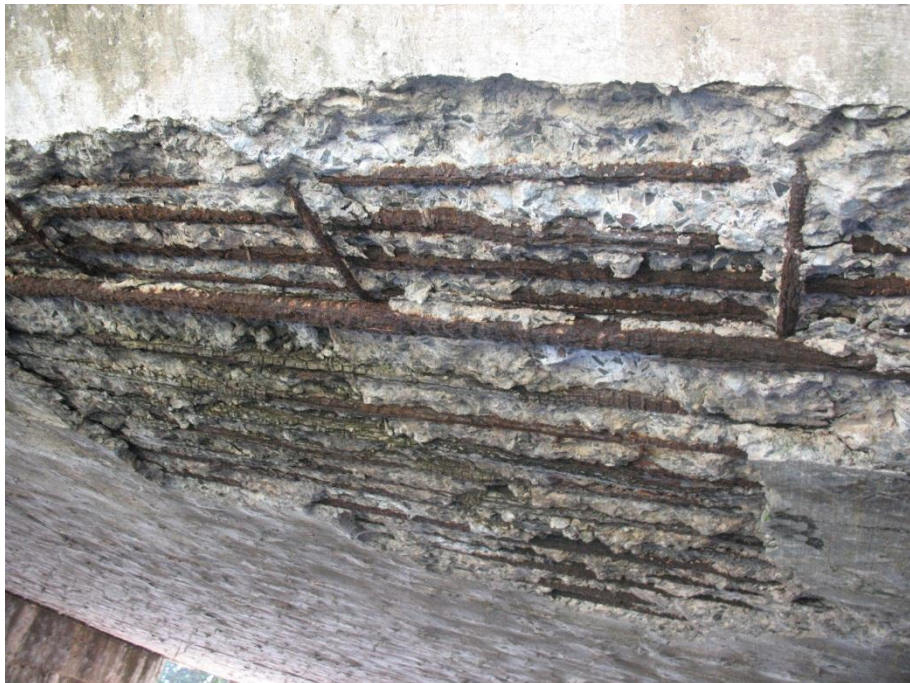
ANEXO 4. Fotografía 4 Puente Conchaliíto.
