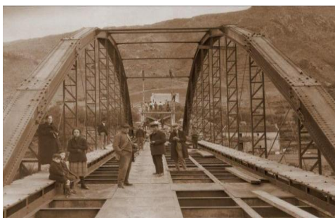
Figura 2.21. Puente de Hierro.
