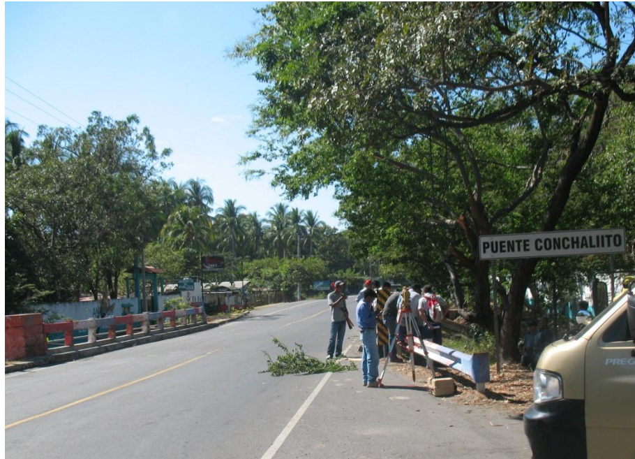
ANEXO 1. Fotografía 1 Puente Conchaliíto.
