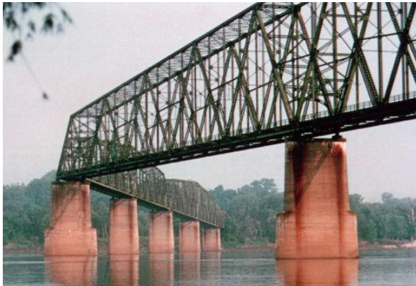
Figura 2.22. Puente de Acero.
