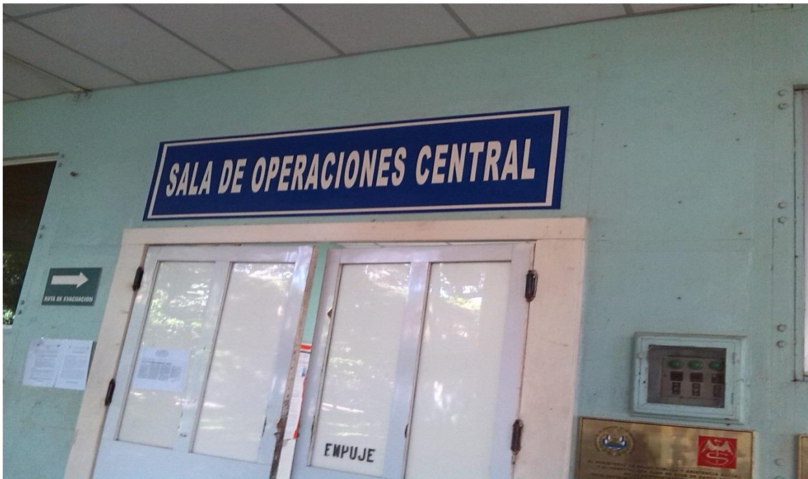
Imagen 4.4 Fachada Centro Quirúrgico
