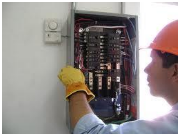
Imagen 5.2 Mantenimiento de Tableros
