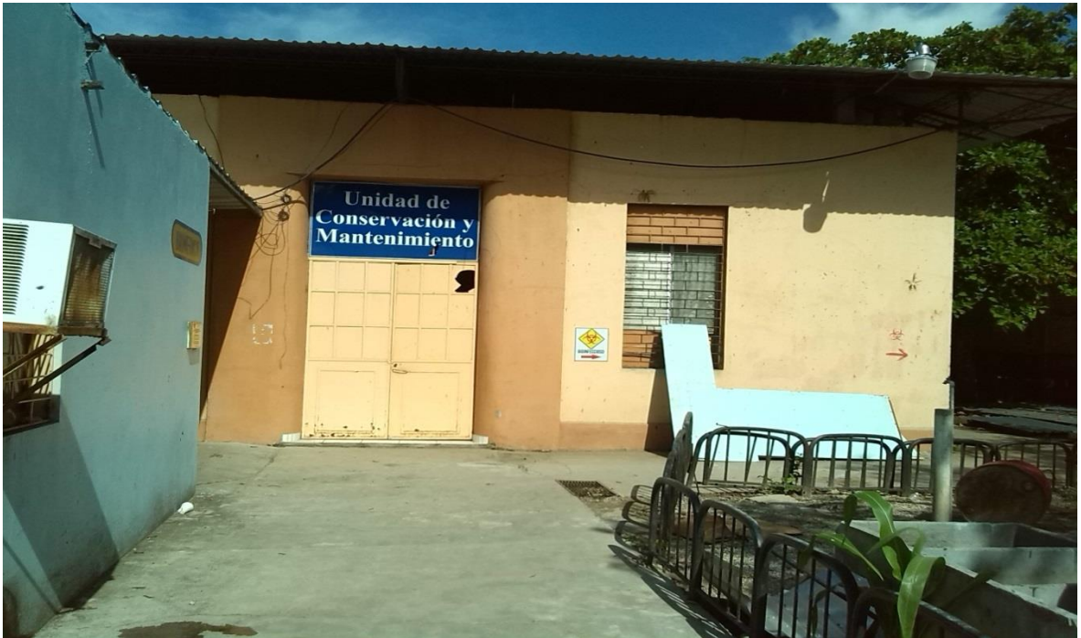
Imagen 4.9 Fachada Unidad de Conservación y Mantenimiento
