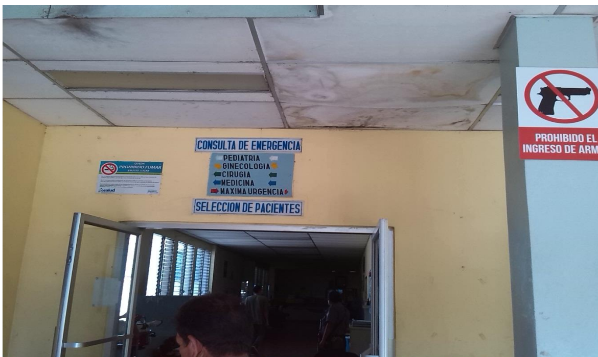
Imagen 4.2 Entrada de la Unidad de Emergencias
