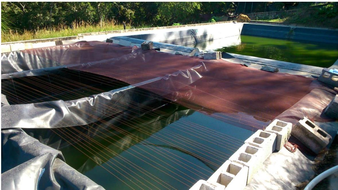
**Figura A-4.** Medidas de seguridad para evitar la entrada de depredadores.
