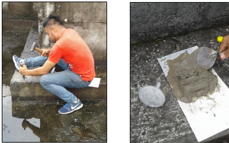
Figura 5.12: Colocación de placa para Base de referencia RTK en Biblioteca FIA.
