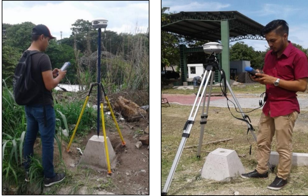
Figura 5.18: Equipos satelitales correctamente instalados, listos para iniciar la medición.
