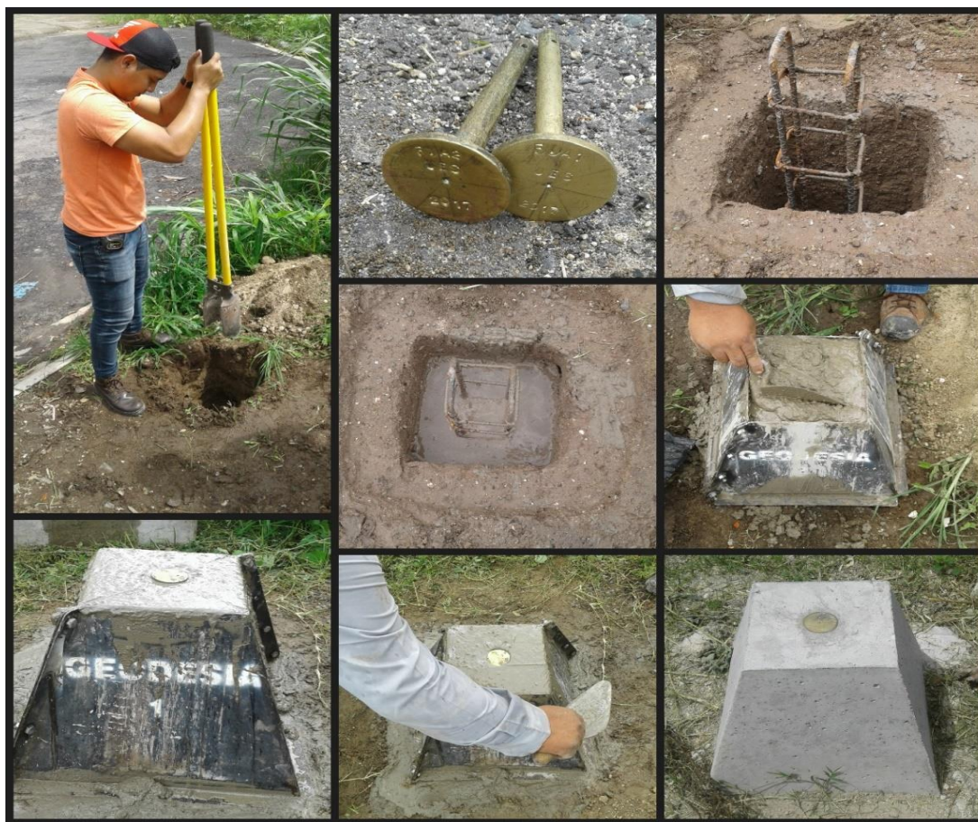
Figura 5.11: Construcción de mojones tipo 3 modificado
