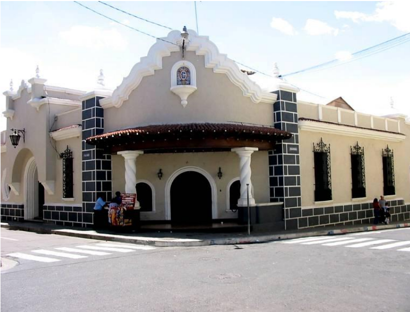
5.2.2.3 Imagen N°5. Casino Santaneco, Fachada Principal.
