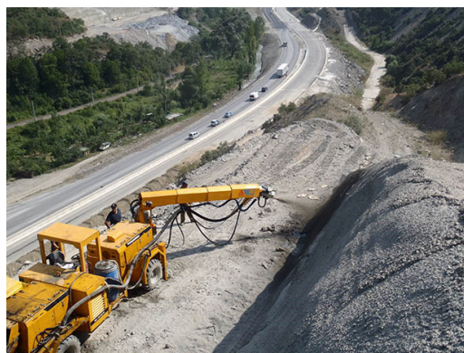
Figura No 6.47: Revestimiento con Shotcrete
