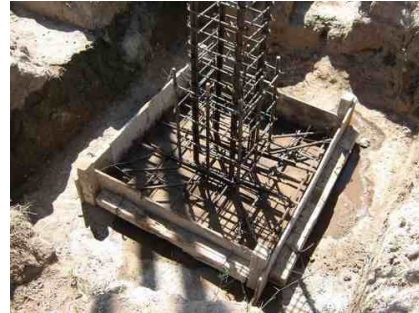
Figura No 1.5: Zapata aislada
