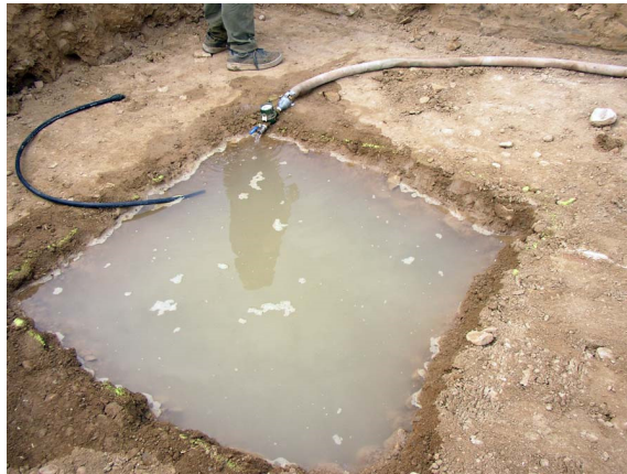
Figura No 1.22: Ensayo de Permeabilidad en un PCA
