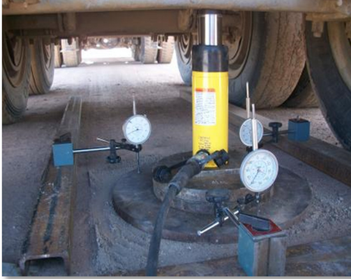
Figura No 1.18: Ensayo de Placa de Carga Estático
