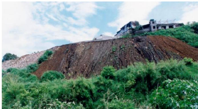
Figura No 6.6: Deslizamiento en un talud por saturación
