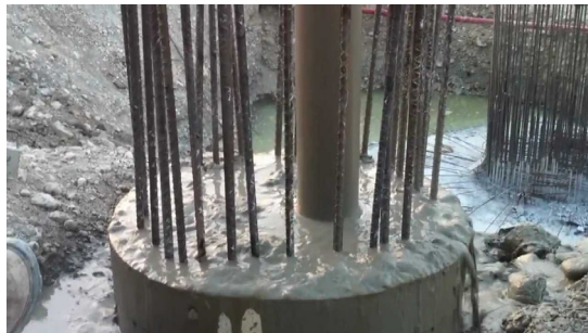
Figura No 5.6: Construcción pilas de cimentación in situ
