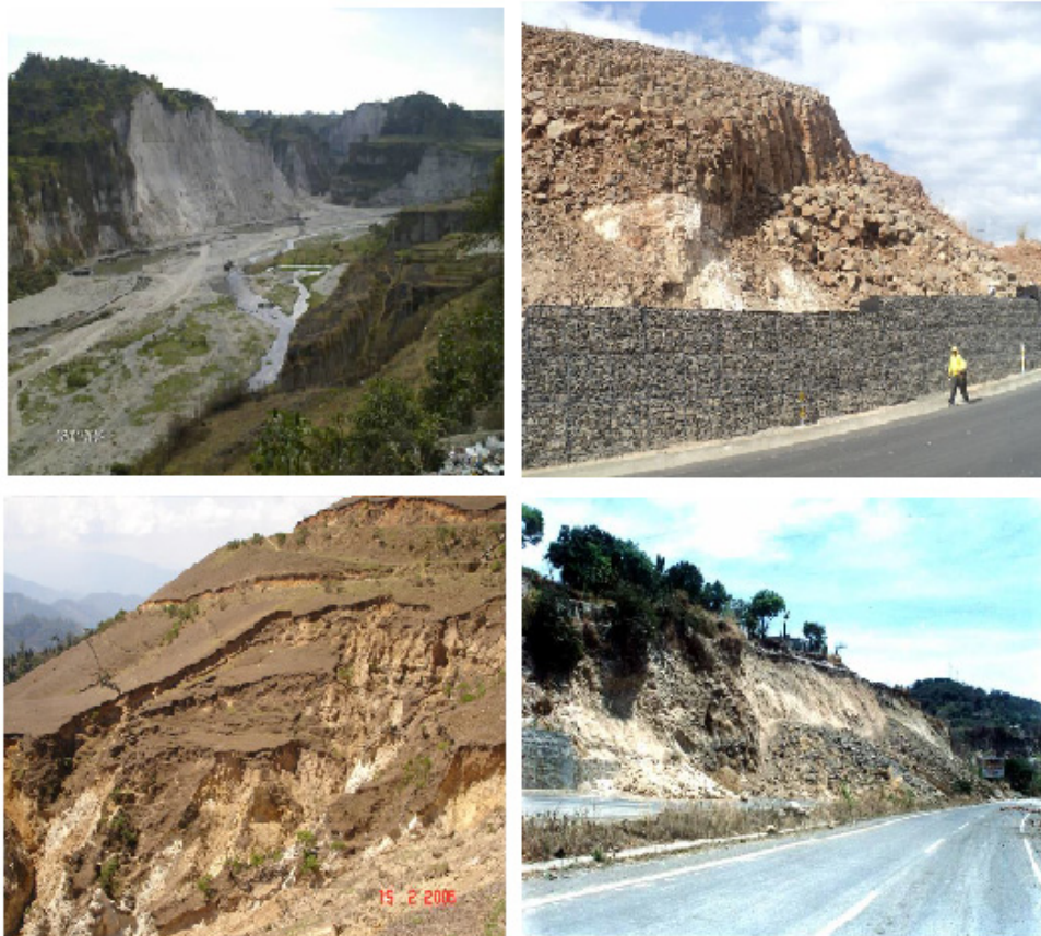
Figura No 6.1: Fotografía de taludes
