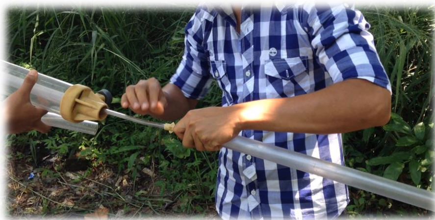
Instalación del tubo principal y de Marriotte.
