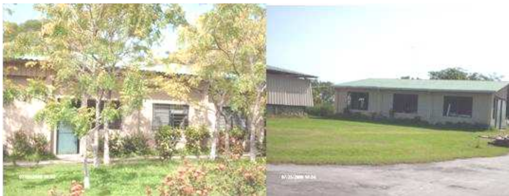
FIGURA 19: Instalaciones para la preparación del personal.
