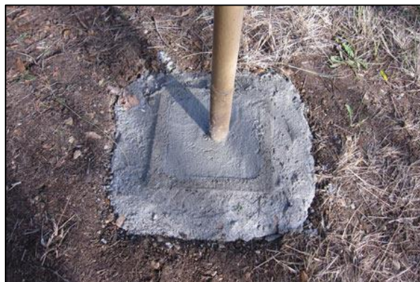
Figura 13. Colado de cemento
