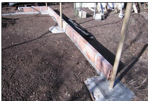
Figura 14. Hilera de ladrillos
