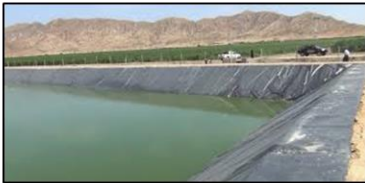
Figura 41. Laguna de oxidación
