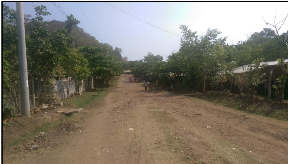
Figura 52 Estado Actual del Derecho de Vía. Avenida Principal.
