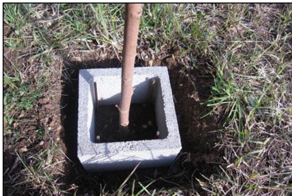
Figura 12. Excavación de cemento
