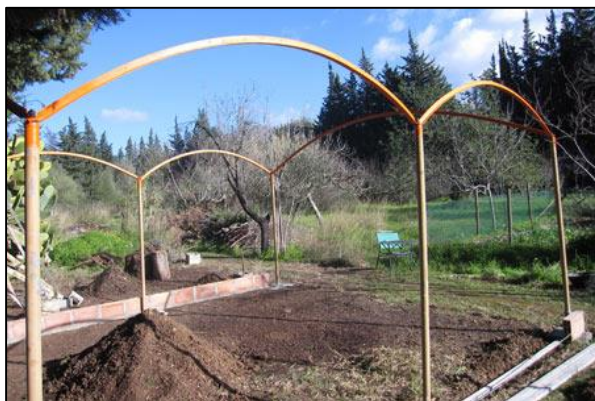
Figura 15. Arcos para el invernadero
