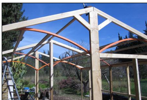
Figura 17. Colocación de pilares
