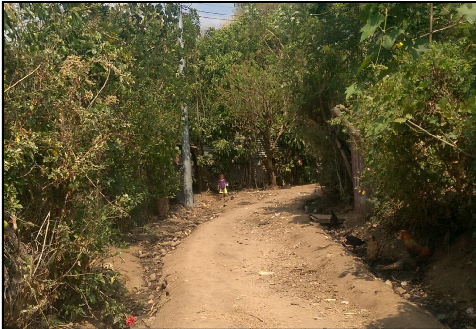
Figura 56 Estado Actual del Derecho de Vía. Pasajes 1,2 y 3.
