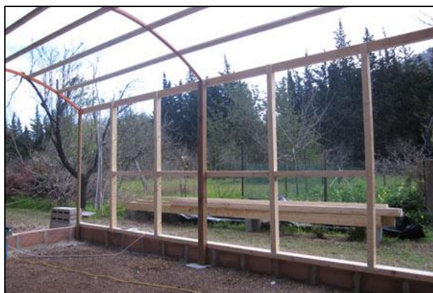
Figura 16. Fijado de estructura
