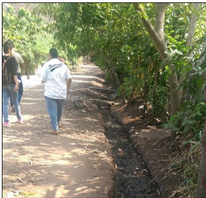
Figura 66. Canaletas de distribución de agua grises
