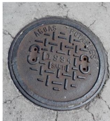
Imagen N° 55 Tapadera de A.P. ubicada en 11 Av. Sur
