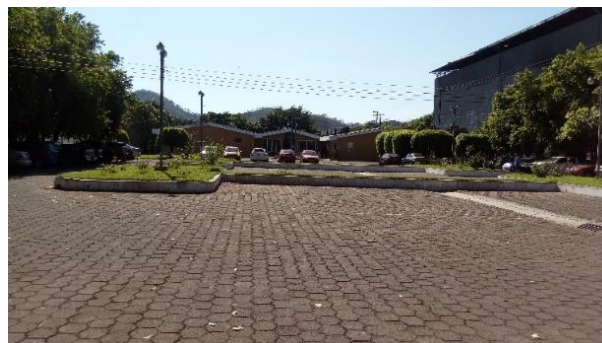
Imagen N° 17 Estacionamiento vista Poniente
