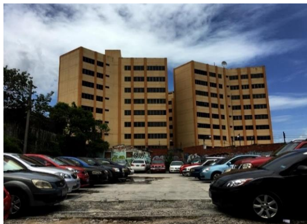
Imagen N° 12 Instalaciones del Ministerio de Hacienda "Tres Torres"
