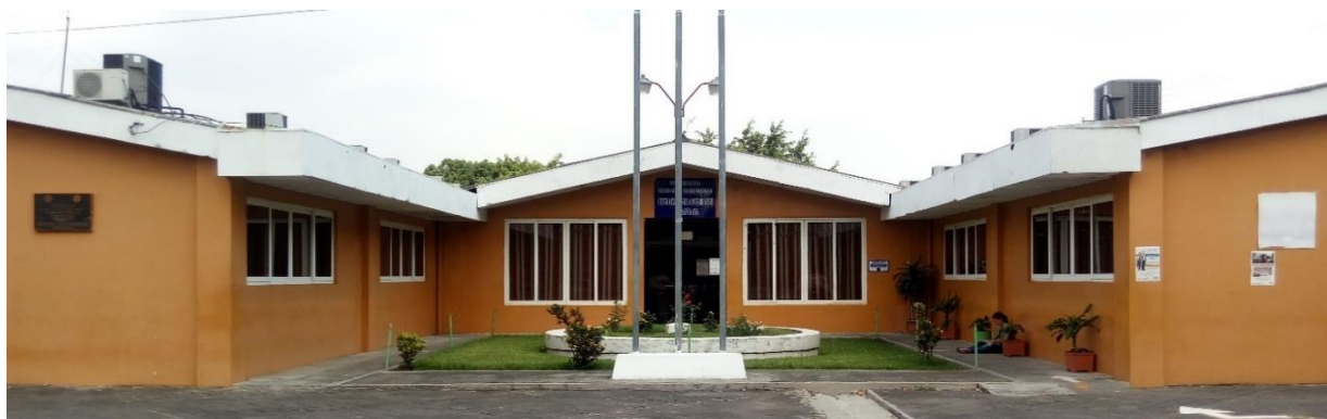
Imagen N° 13 Elevación principal de las Instalaciones de Santa Ana
