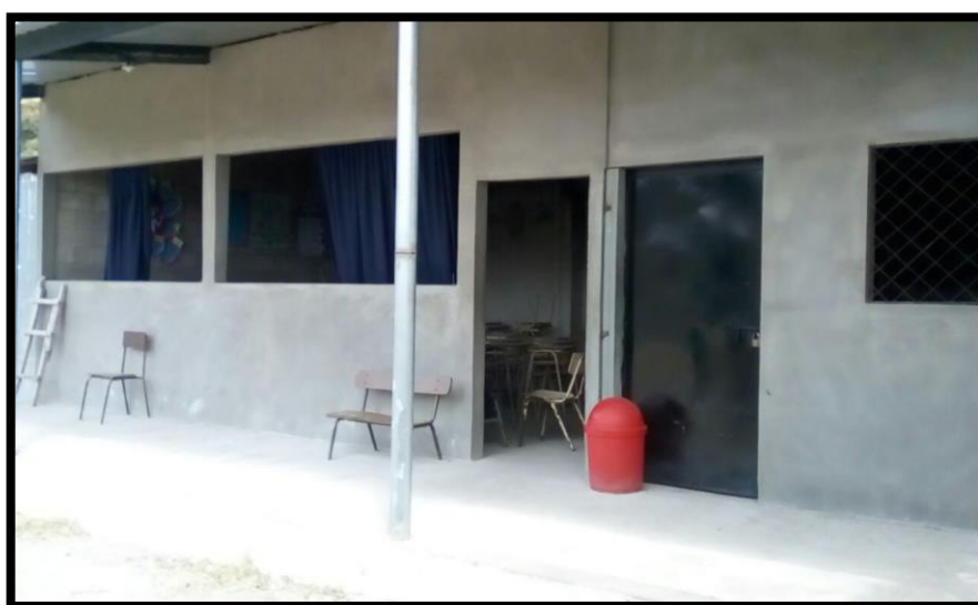
Figura 52 Aula sin finalizar (izquierda) y biblioteca (derecha)
