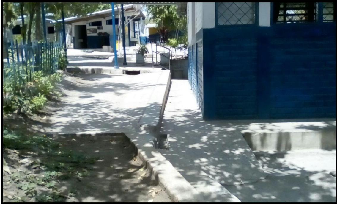
Figura 116 Pasillo oeste, bloque 1
