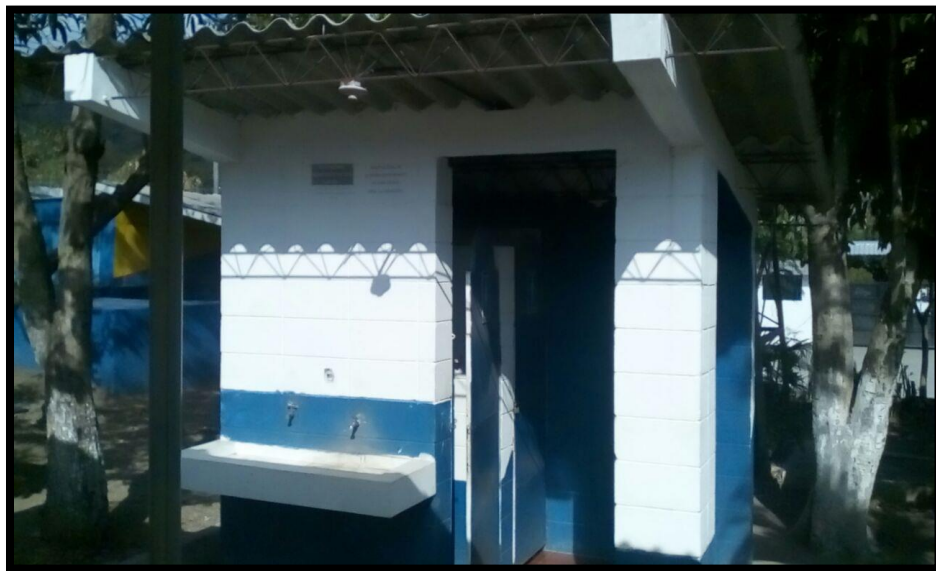
Figura 56 Servicios sanitarios para el personal
