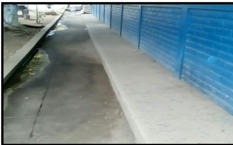
Figura 60 Canaleta en costado sur de Bloque 2
