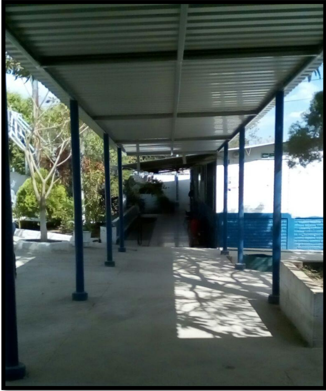
Figura 112 Pasillo que comunica Bloque 1 y Bloque 4
