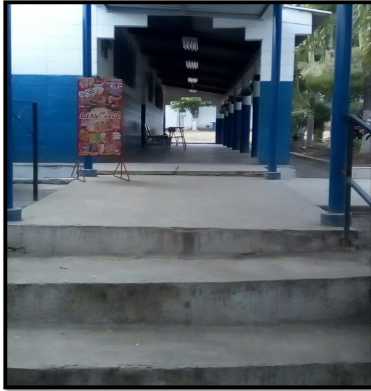
Figura 114 Pasillo que comunica bloque 2 y bloque 3
