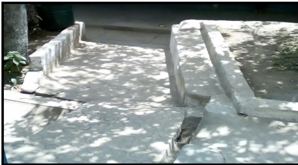
Figura 48 Rampa de comunicación entre bloque 1 y bloque 2
