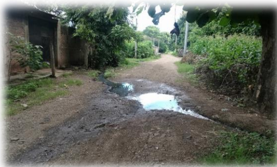
Imagen 80: Estancamiento de aguas grises en calle de acceso a antiguo cementerio
