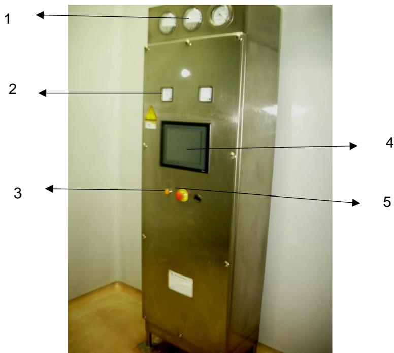
Figura N°9. Vista frontal del Panel de control del Secador de Lecho Fluido YENCHEN, Modelo YC-SEP-FBD-60.
