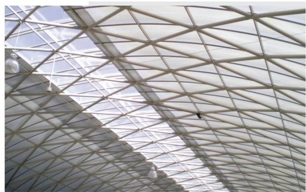
Ilustración 50- Estructura cubierta con policarbonato
