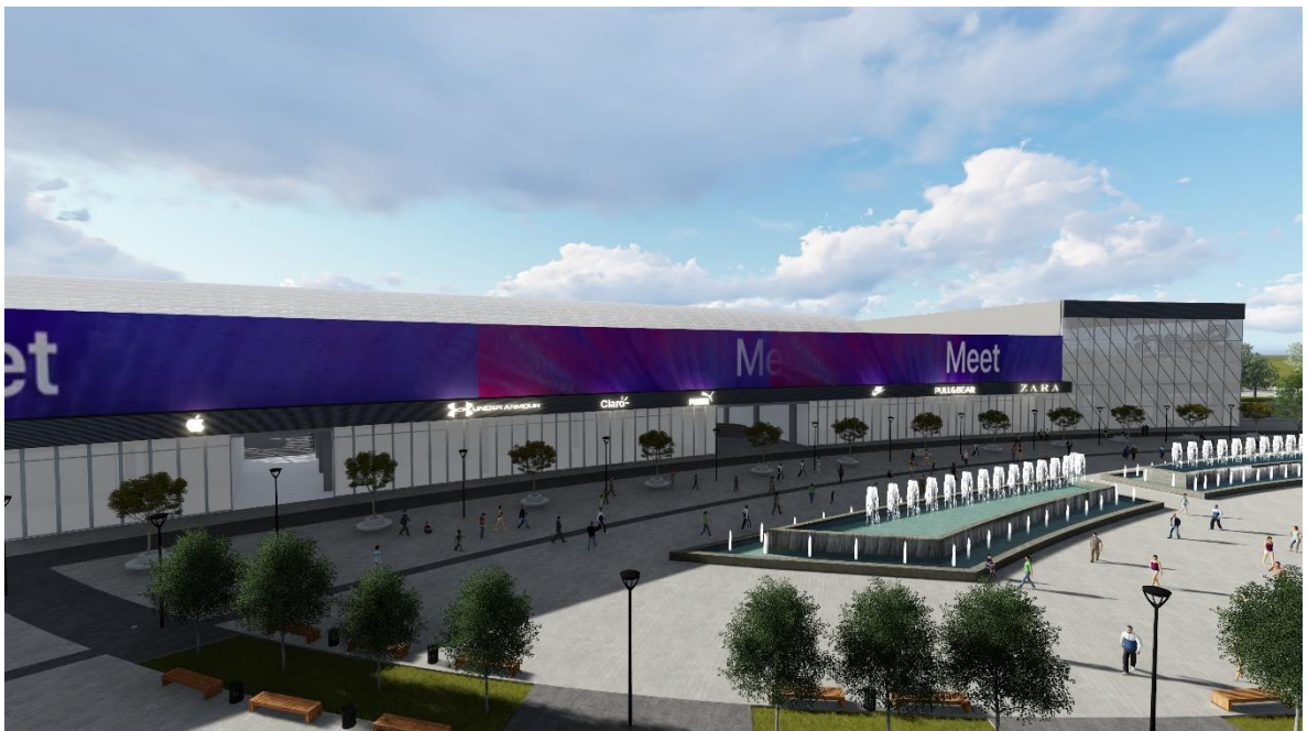
VISTA PANORAMICA DE FACHADA ESTE DE CENTRO COMERCIAL MUNICIPAL
