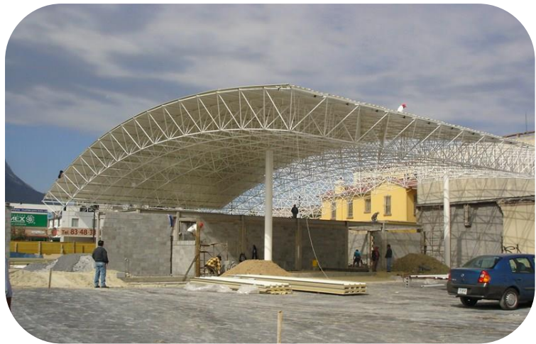
Ilustración 48- Ejemplo de Estructura Espacial
