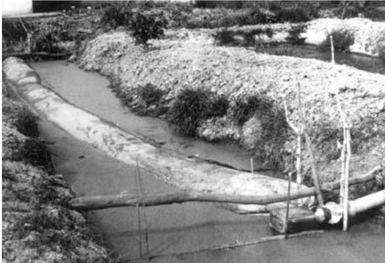
**Figura 1.4** Biodigestor Flotante. (ONI, 2004)
