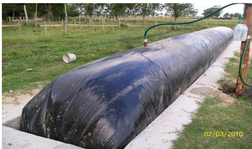
**Figura 1.3** Biodigestor de Estructura Flexible. (ONI, 2004)
