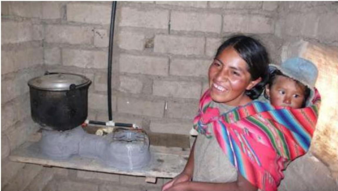
Figura A37.5: Cocina de biogás con estructura de barro, divididos por una conexión en te para cada quemador. Fuente: PEJ, KLJB & Bethlehem Mission Immensee.
