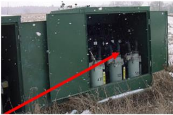
Ilustración 4. 9 Bushing del transformador Caliente
