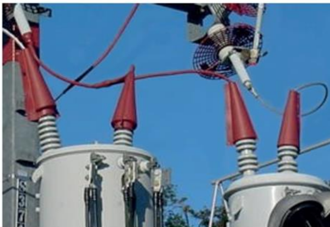
Ilustración 4.34 Protección Avifauna en los terminales del transformador, apartarrayos y cortacircuitos.
