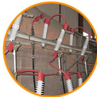
Ilustración 4.34 Protección Avifauna en los terminales del transformador, apartarrayos y cortacircuitos.
