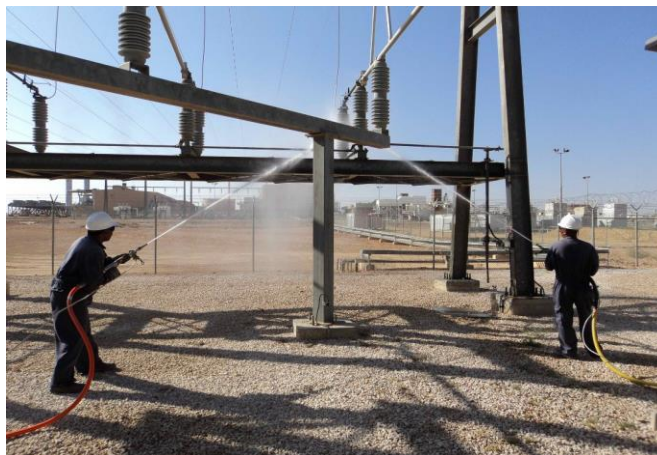
Ilustración 4. 12 Limpieza de los aisladores
