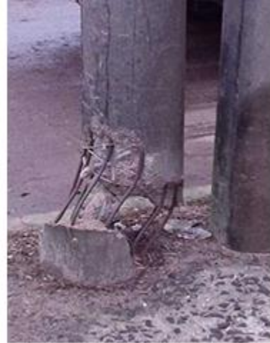
Ilustración 4. 2 Poste quebrado fuera de la vertical, con armadura expuesta.
