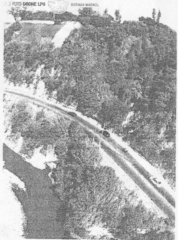
Ampliación. El MOP espera avanzar en la colocación del puente paralelo antes de que comience de lleno la estación lluviosa.
