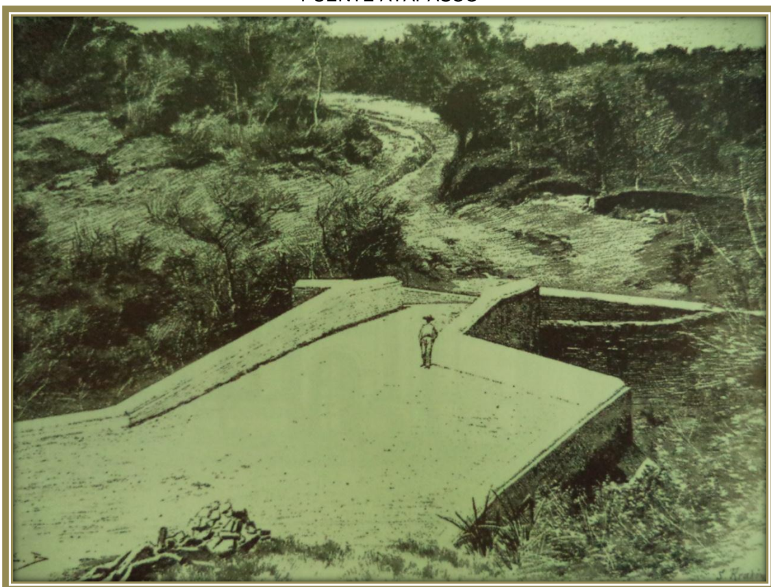
FOTOGRAFÍA No. 3: PUENTE ATAPASCO
