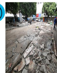
Ilustración 27. Escombros posteriores a desalojo. Fuente propia.
