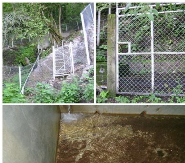
Figura. 11. Protección de manantiales
