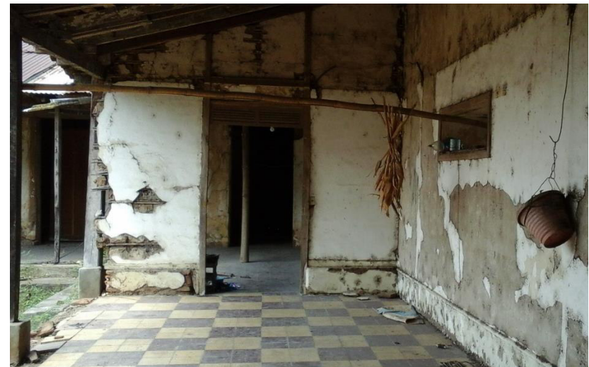
Fotografía MA-6. Hueco de puerta, acceso a cocina
