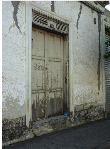
Fotografía MA-5. Puerta con acceso a oficina
