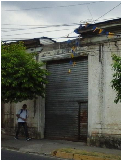
Fotografía MA-4. Portón, acceso principal
