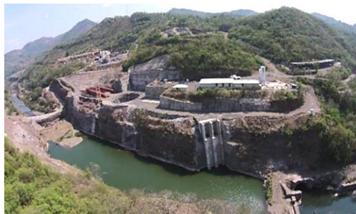
Imagen 2.19 Construcción de Central El Chaparral en 2015 25
