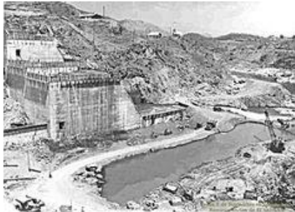
Imagen 2.3 Construcción de la Presa 5 de Noviembre en 1952 7
