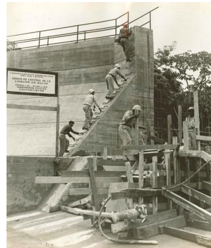
Imagen 2.7 Construcción de Presa Guajoyo en 1963 12
