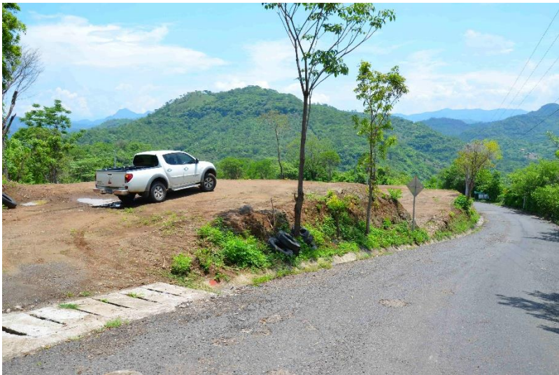
58 Fuente Propia. Imagen 5.2 Vista hacia acceso existente en terrazas
