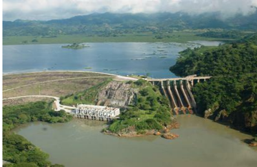
Imagen 2.12 Central Hidroeléctrica Cerrón Grande. 17
