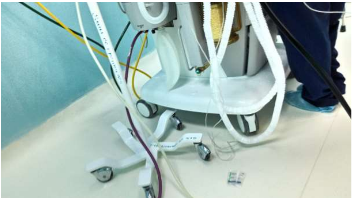
Imagen 4.70 Apoyos de equipo de quirófanos
