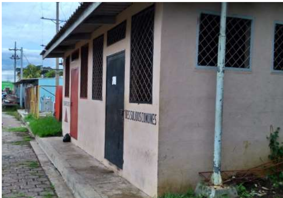
Imagen 4.51 Caseta de desechos comunes y bioinfecciosos
