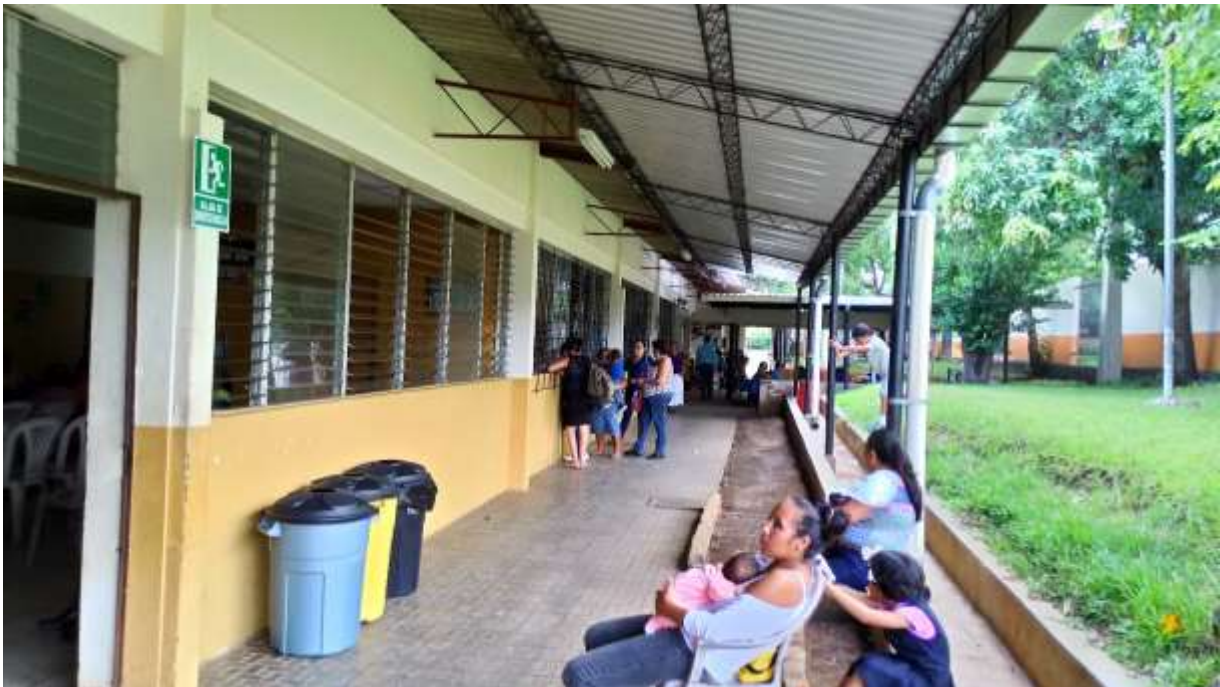
Imagen 4.76 Ventana tipo solaire en el área de Consulta Externa
