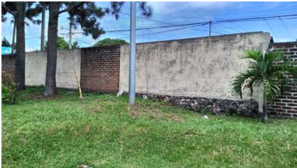
Imagen 4.13 Muro Perimetral desplomado.
