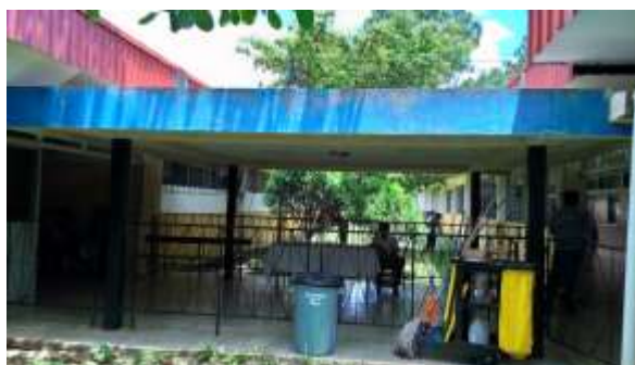
Imagen 4.9 Losas en los pasillos del Hospital.
