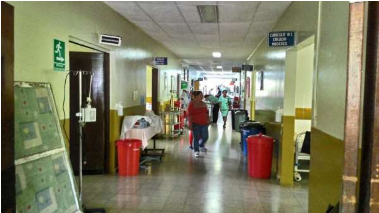
Imagen 4.75 Pasillo del módulo de medicina obstruido
