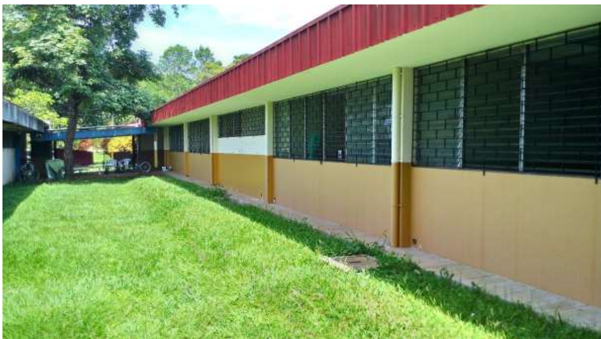
Imagen 4.30 Exterior del módulo de Maternidad.
