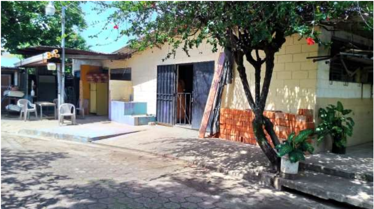
Imagen 4.48 Entrada al edificio de mantenimiento.
