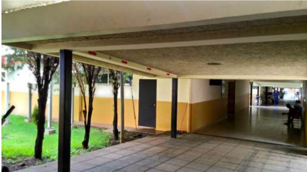
Imagen 4.10 Vista Interior de las losas en pasillos.
