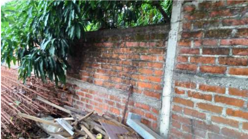
Imagen 4.13 Muro Perimetral desplomado.
