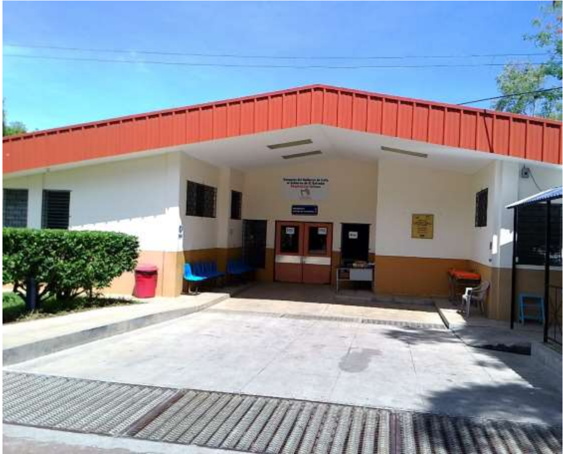
Imagen 4.20 Entrada al módulo de emergencias
