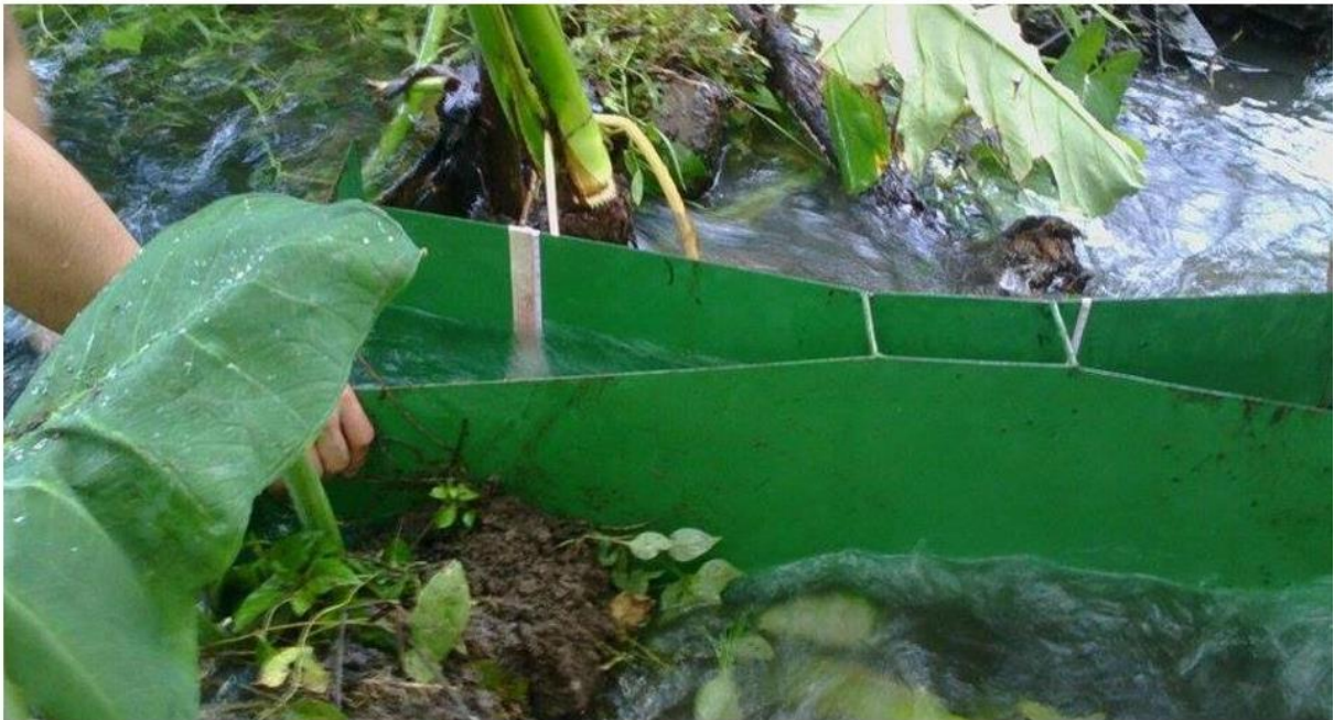
Fotografía 3. Instalación de Canaleta Parshall.
