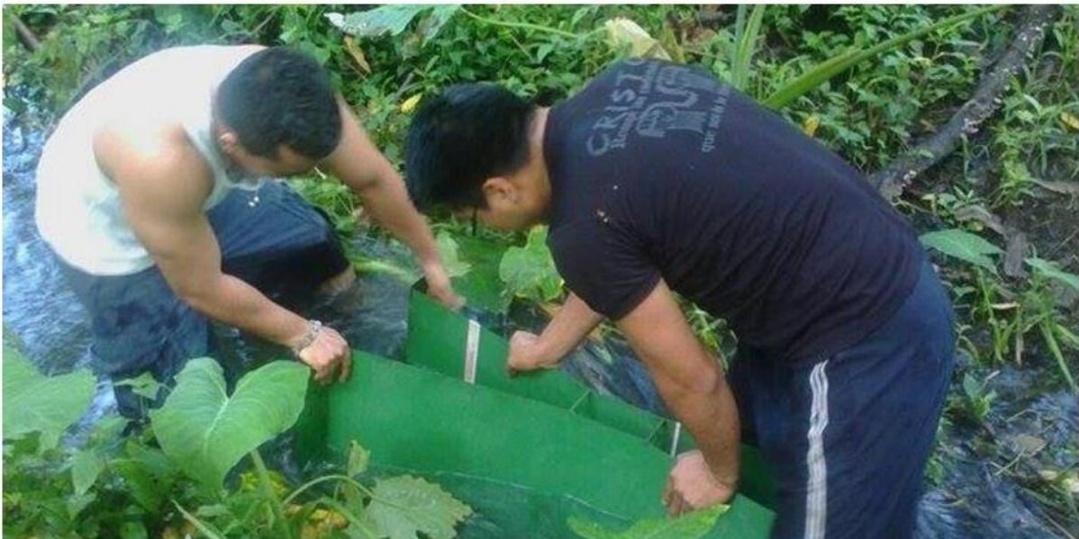
Fotografía 2. Instalación de Canaleta Parshall.
