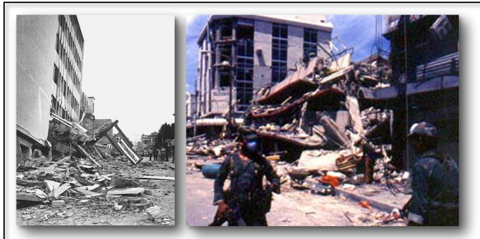
Figura 2.8. A la derecha edificio Gran Hotel de El Salvador colapsado parcialmente, a la izquierda edificio Rubén Darío totalmente colapsado. San Salvador, terremoto del 10 de octubre de 1986.
