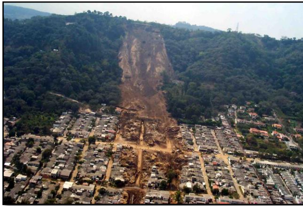
Figura 2.9. Desprendimiento de suelo en La Cordillera del Bálsamo, sobre Las Colinas, Santa Tecla.
