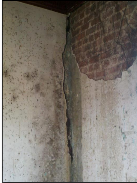
Figura 5.19 y Figura 5.20 Muestran las fisuras entre paredes perpendiculares.
