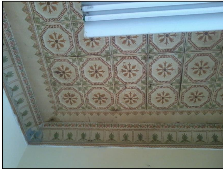
Figura 5.9 Vista del cielo falso de lámina repujada.
