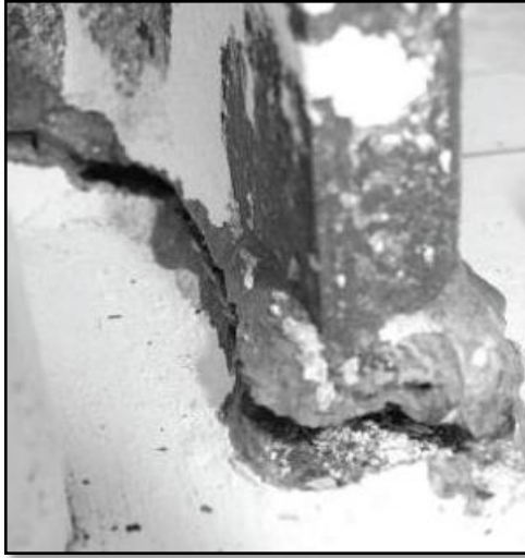
Figura. 3.18. Fractura en el cordón de soldadura
