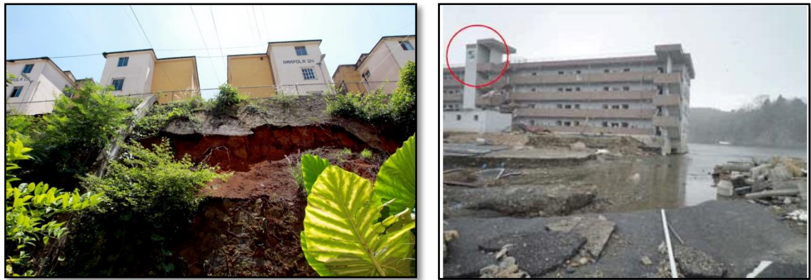
Figura 3.30. A la izquierda: foto de viviendas cercanas a una ladera erosionada; derecha: Edificio de evacuación (círculo rojo) de Minamisanriku (Japón) con accesos socavados.
