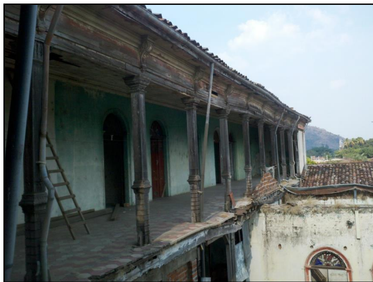
Figura 5.18 Vista del segundo nivel de la edificación.
