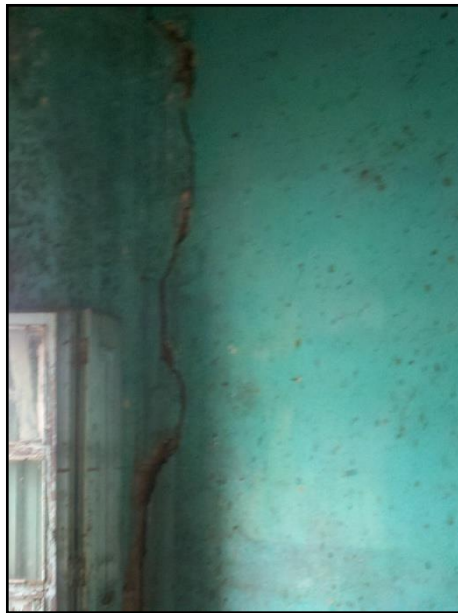
Figura 5.21 y Figura 5.22 Muestran las fisuras entre paredes perpendiculares.
