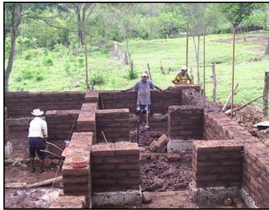
Figura.3.31. Mampostería de adobe sistema tradicional.
