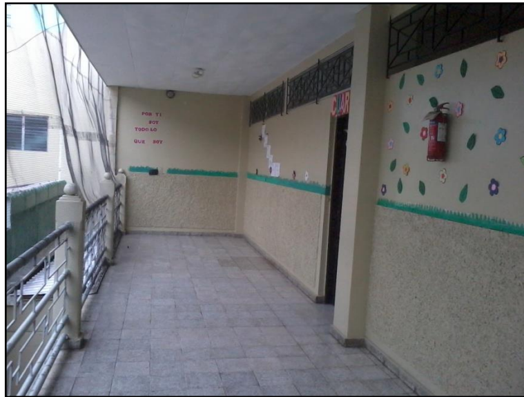
Figura 5.1 Se aprecia el pasillo de edificio norte del colegio y las columnas de concreto.
