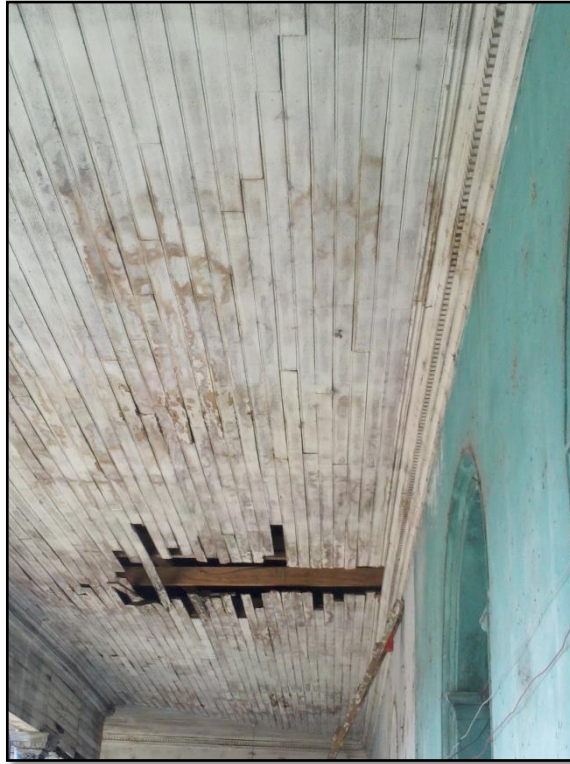
Figura 5.23 Vista del cielo falso del segundo nivel de la edificación.
