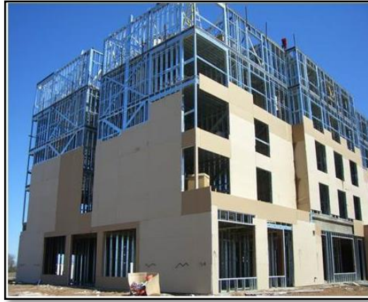
Figura 3.34 Construcción con perfilería de acero.
