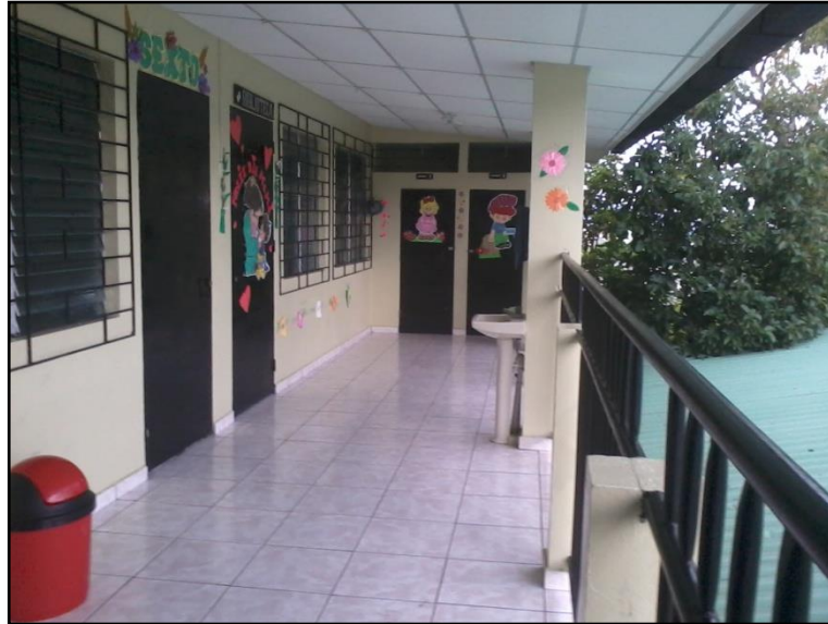
Figura 5.2 Muestra el pasillo del edificio este y detalles como pasamanos, cielo falso y mantenimiento a la estructura
