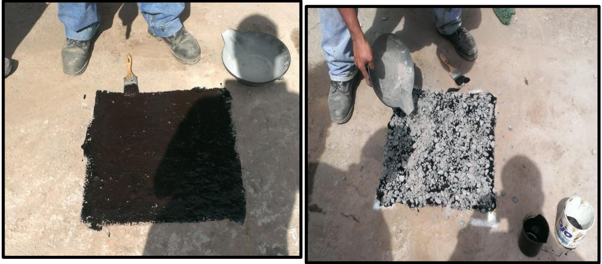
Primera capa de emulsión y sobre ella primera capa de agregado de 3/8”
