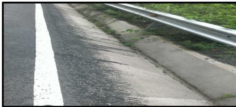
FIGURA # 2. 6 Emulsión y agregado derramado en cuneta
