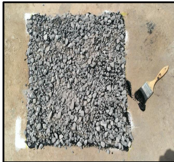
Primera capa de doble tratamiento aplicado
