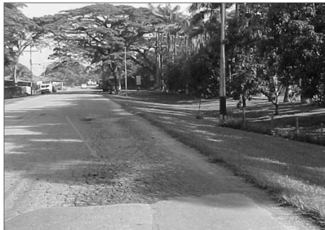
Figura 2.4 agrietamiento.
