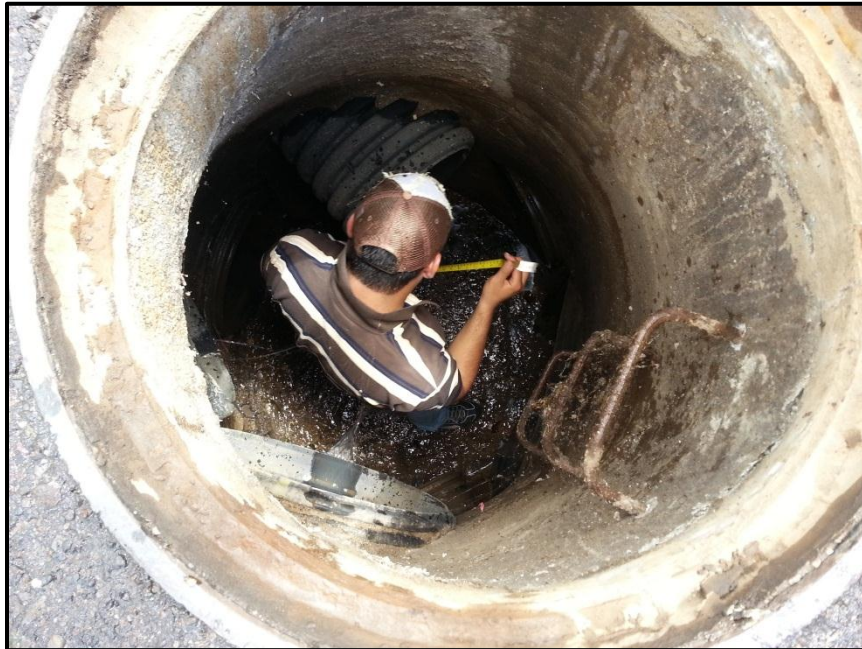
Ilustración 3.16 Verificación de Material, Diámetro y Diferencia de Nivel en Colectores.
