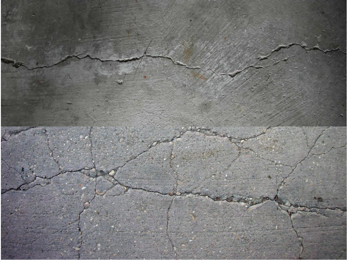
Figura 2.8.6. Tipos de contracción comunes en el concreto a edades avanzadas.
