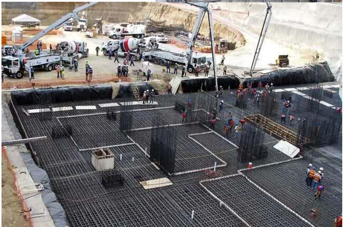
Figura 2.8.2. Concreto bombeado en espacios confinados donde se requiere unas adecuadas propiedades en estado fresco del concreto, en especial en su consistencia.
