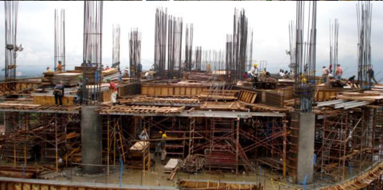
La figura representa la etapa constructiva del Edificio Torre Futura
