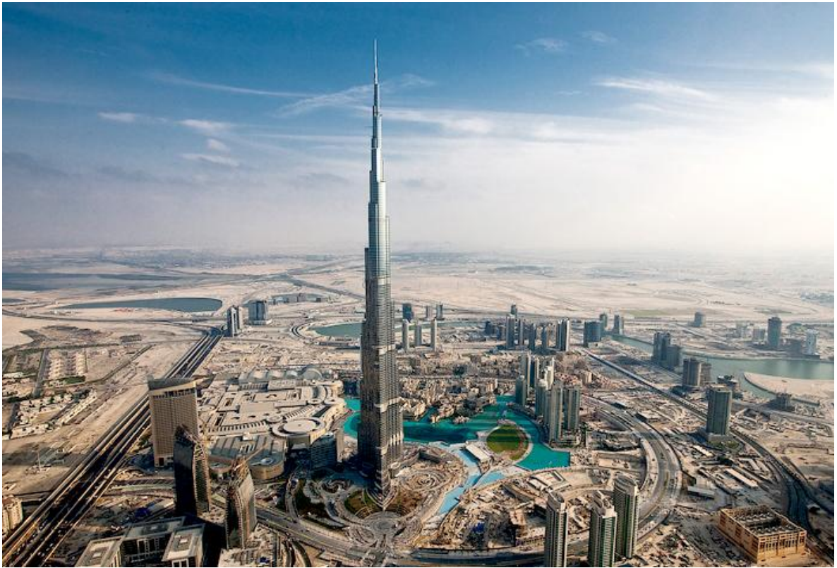
Figura 2.3.3. Burj Khalifa, Dubai, Emiratos Árabes Unidos. El edificio más alto del mundo con una altura de 828 m y finalizado en 2009. Construido con concreto de Alta Resistencia y con muy baja permeabilidad en su fundación. Y con un sistema de protección catódico utilizado para minimizar los efectos perjudiciales de los productos químicos corrosivos en el agua subterránea local.
