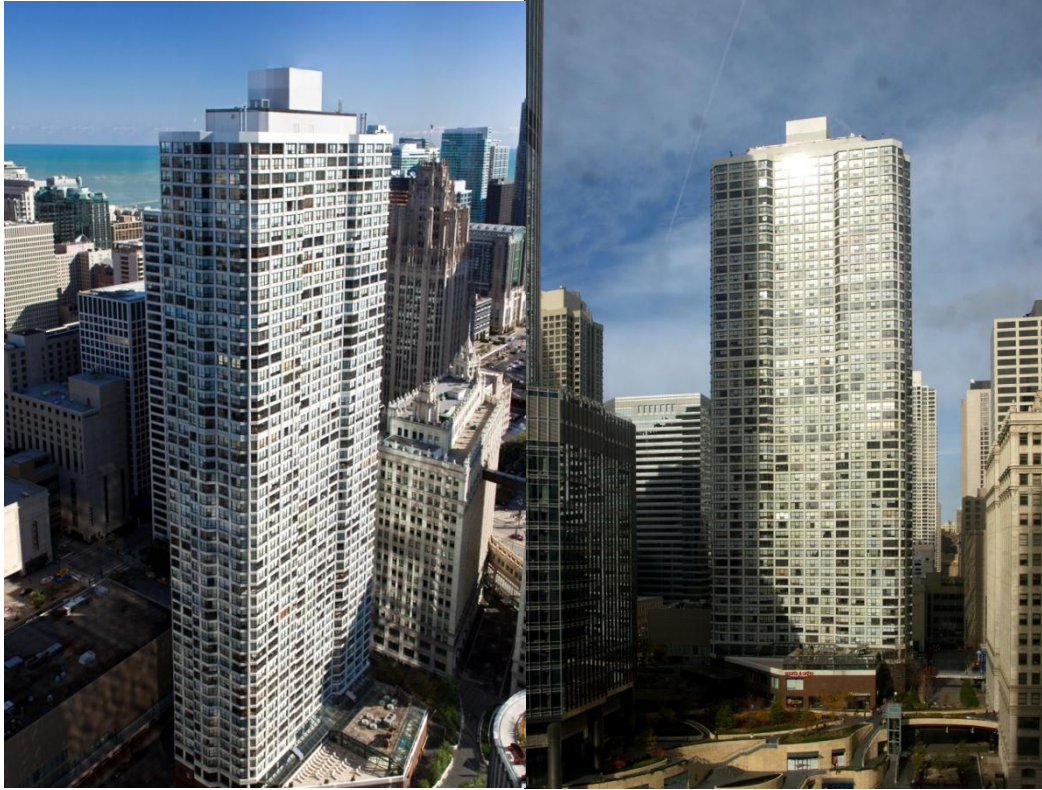
Figura 2.3.2. River Plaza elaborado con un f'_c = 77 MPa. Es un ejemplo de edificios altos construido en 1976 en el área de Chicago, Illinois, Estados Unidos.
