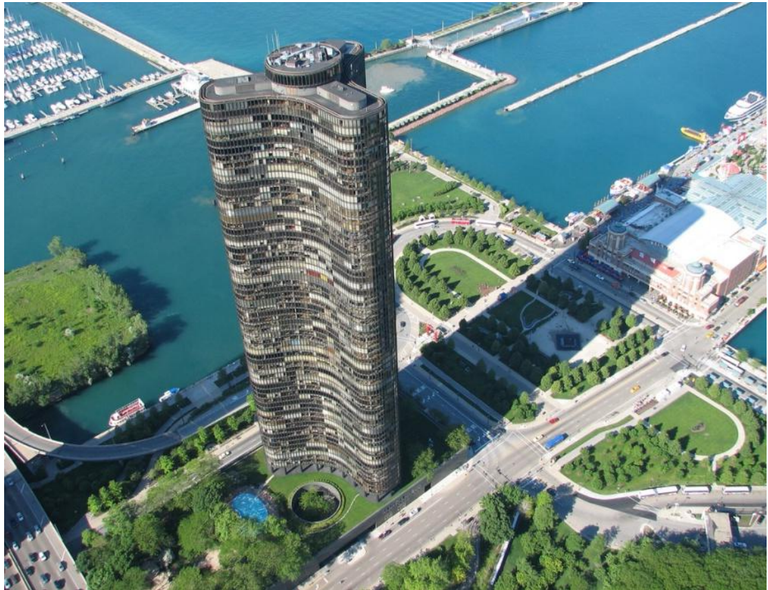
Figura 2.3.1. Lake Point Tower con un f'_c = 53 MPa. Es un ejemplo de edificios altos construido en 1965 en el área de Chicago, Illinois, Estados Unidos.
