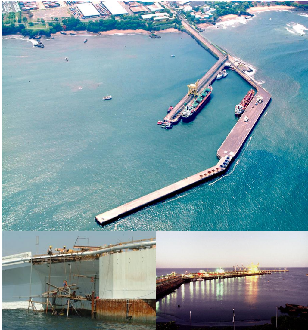
Figura 2.2.3. Reparación del Puerto de Acajutla, El Salvador; con Concreto de Alta Resistencia y resistencia al ataque de sulfatos. Mejorado con Microsilice como adición.
