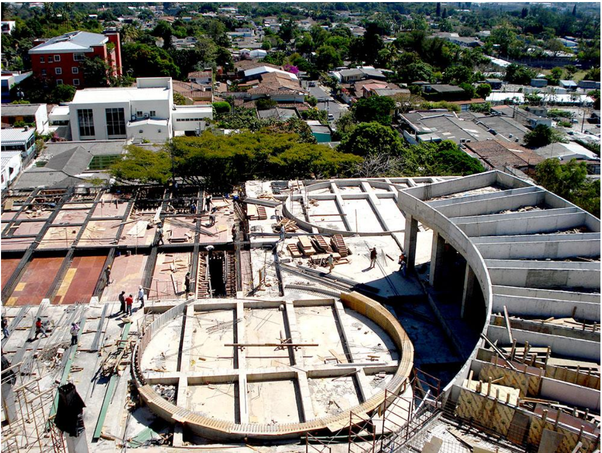
Figura 2.6.3. Construcción del Edificio Torre Futura, San Salvador, El Salvador.
