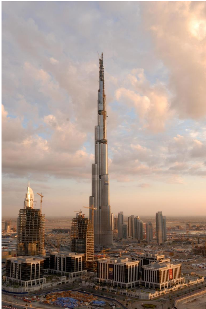
Figura 2.6.1. Burj Khalifa, Dubai, Emiratos Árabes Unidos. El edificio más alto del mundo con una altura de 828 m y finalizado en 2009.
