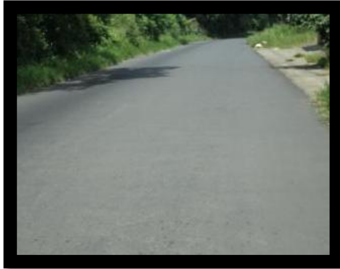
Figura # 5.8 Pavimento en buenas condiciones de servicio.
