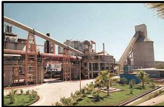
Figura 2.2 Plantel “El Ronco” de producción de cemento en El Salvador.
