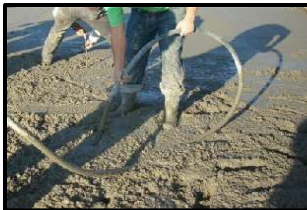
Figura 2.24 Vibrado del concreto en obra.
