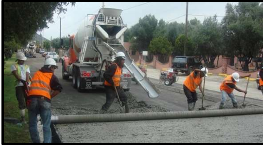
Figura 2.20 Colocación de concreto en estado fresco.
