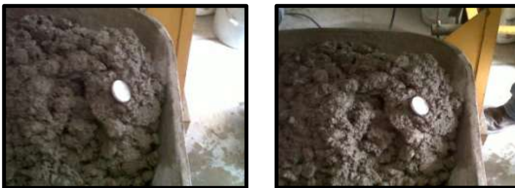
Figura 4.2 Medición de temperatura en mezcla de concreto hidráulico.
