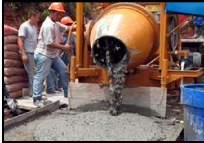
Figura 2.21 Obrero elaborando concreto mediante una concretora.
