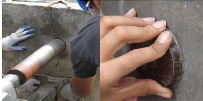
*Figura5.15: Perforación de pared con broca hidráulica y pegado de pastilla sobre mortero.*
