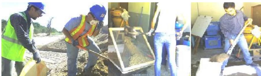
*Figura 3.1: preparación de material selecto, muestreo, tamizado y almacenamiento.*
