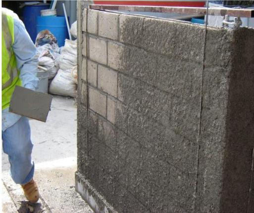
a) Repello de espesor 5mm, pared 1 cara I, proporción 1:3.
