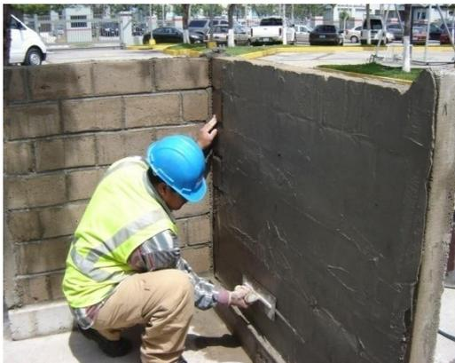
c) Repello de espesor 1mm, pared 1 cara II, proporción 10:1.
