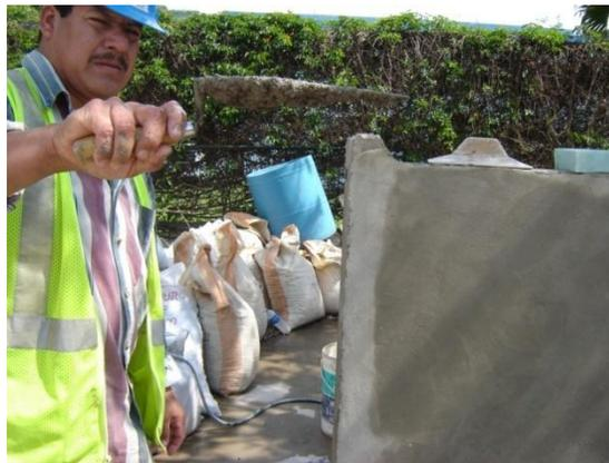
*Figura 3.10: Prueba de la cuchara realizada por el albañil*
