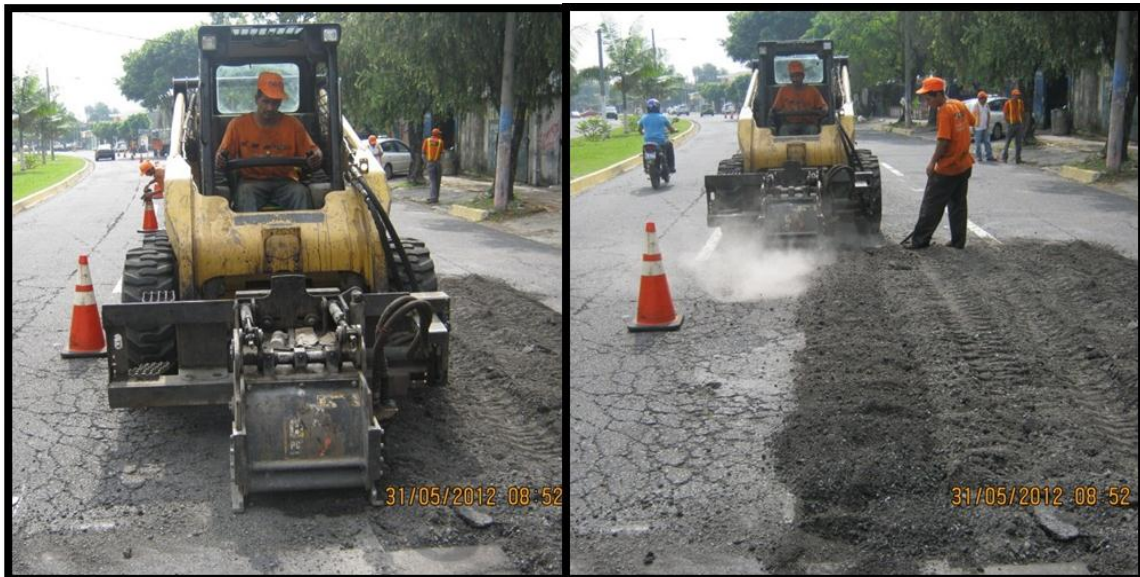
Figura 3.16: Actividades de bacheo superficial con fresadora PC204
