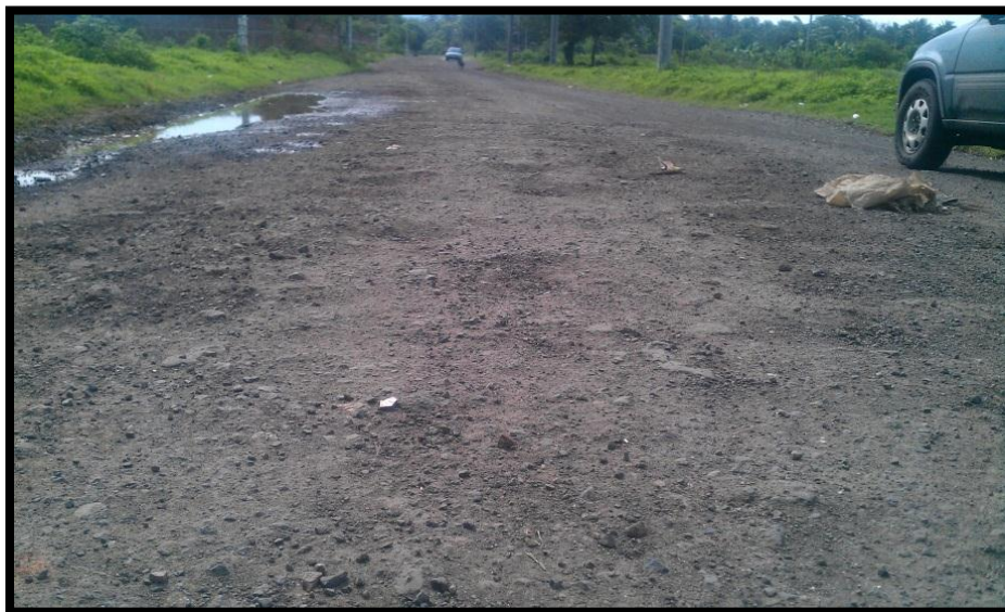
Figura 4.1: Aspecto actual del camino no pavimentado
