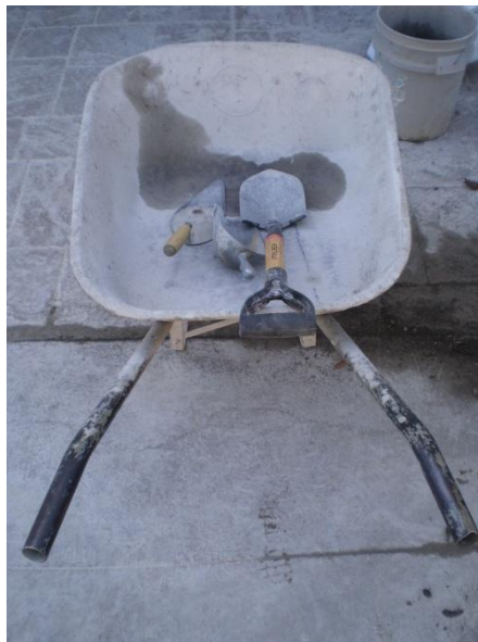
Fotografía No. 23 Carretilla y Equipo adicional.
