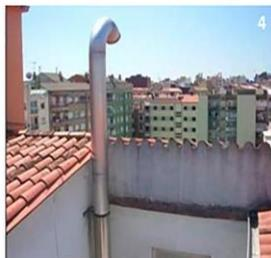
Chimenea de evacuación del helio gas: 1.- Conexión de la chimenea en la jaula de Faraday; 2.- Equipo con la chimenea acabada; 3 y 4.- Aspecto exterior de la chimenea. Se trata de un equipo Signa 1,5 T de G. E.
