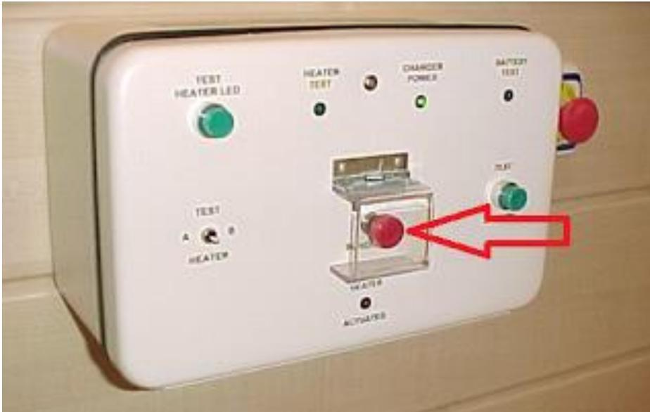
**FIGURA 2)** Pulsador de emergencia (Flecha roja) para expulsar el helio del tanque.
