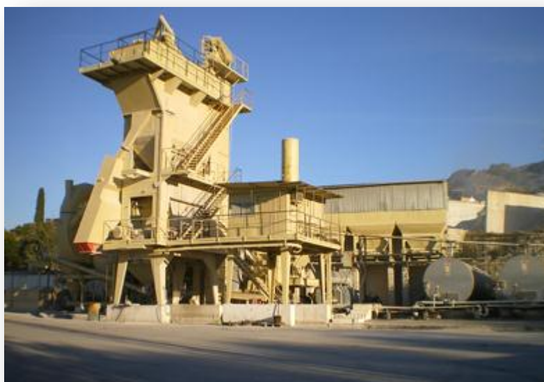
IMAGEN 5.1: Planta asfáltica discontinua.
