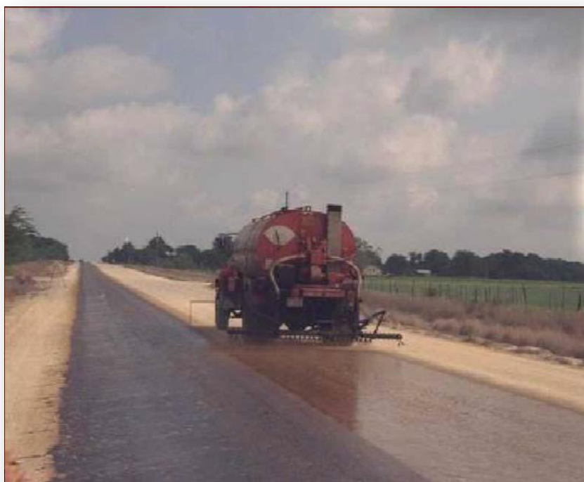
IMAGEN 5.4: Riego de imprimación
