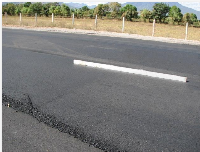
IMAGEN 5.7: Verificación de irregularidades en zona de junta transversal, mediante el empleo de un escantillón.
