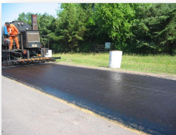
IMAGEN 5.5: Equipo ejecutando riego de liga sobre superficie a recubrir
