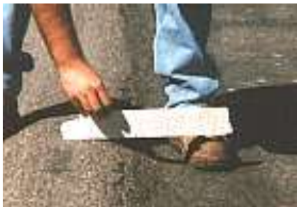
Figura 2.25 Deformaciones plásticas permanentes en pavimentos asfálticos. (MEZCLAS ASFALTICAS, ALEJANDRO PADRILLA RODRIGUEZ, PAG 63 y 64)
