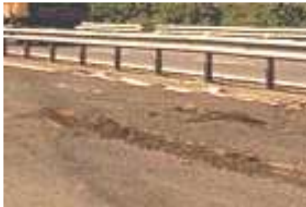
Figura 2.21 Desenvuelta o Desplazamiento de los agregados en pavimentos asfálticos. (MEZCLAS ASFÁLTICAS, ALEJANDRO PADRILLA RODRIGUEZ, PAG 58)
