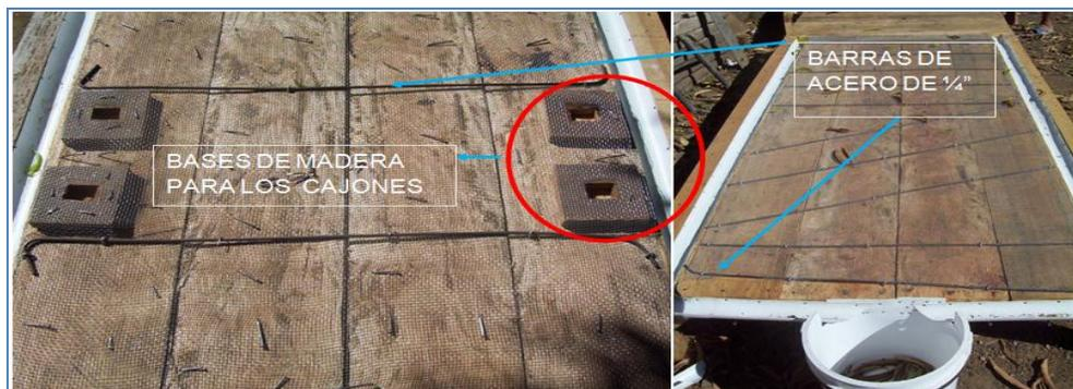
**Fotografía 9:** “Preparación de la Superficie con Cedazo y Barras de a 1/4”.
