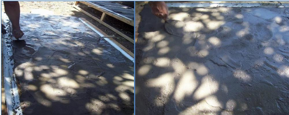
**Fotografía 11.** “Colocación de Mezcla, sobre la superficie de madera”.
