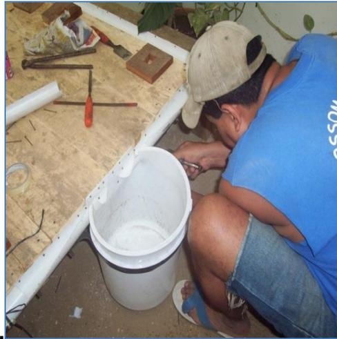
**Fotografía 8.** “Colocación de las cubetas que funcionaran como pequeñas balsas de lixiviados”.
