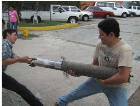
**Figura 5.10 Desmoldado de la tubería propuesta.**
