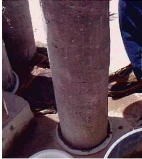
**Figura 8.11 Colocación del tubo para sellado**
