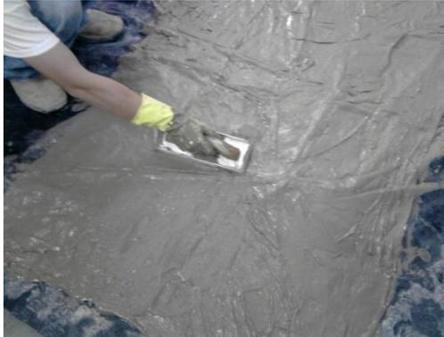
**Figura 5.7 Uniformización de la pasta de cemento en el textil.**
