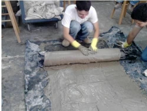
**Figura 5.8 Envoltura de la tubería.**
