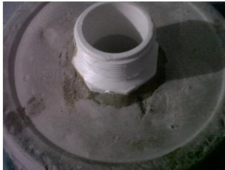
**Figura 8.13 Adaptador macho, sellado y pegado con “Sika primer MB”**
