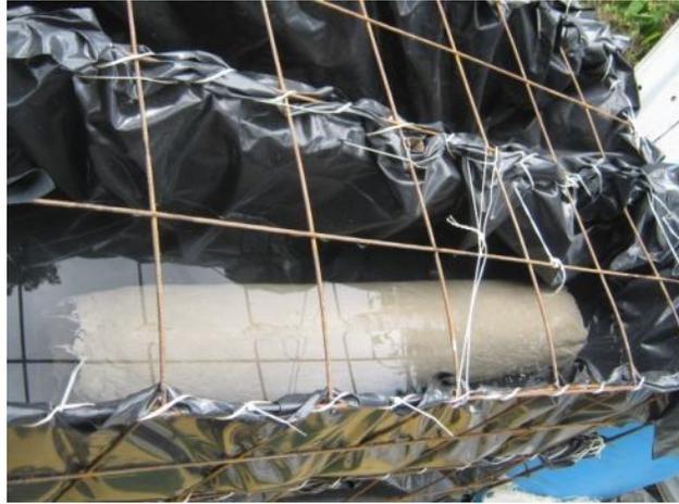
**Figura 5.12 Tubería propuesta en proceso de curado.**
