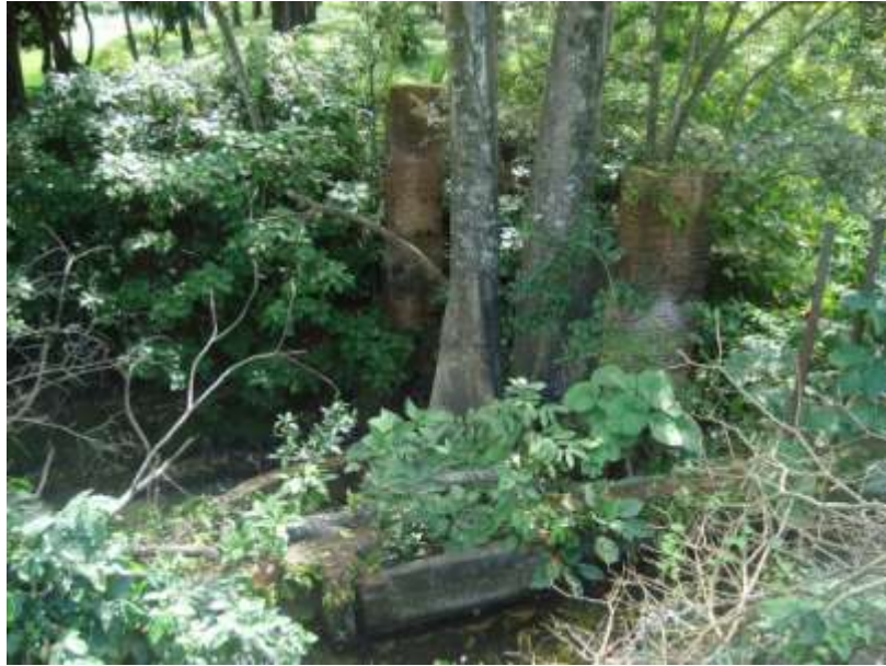
Foto 9. Punto más alto donde pasará la canaleta en el cual es necesario realizar corte del terreno.
