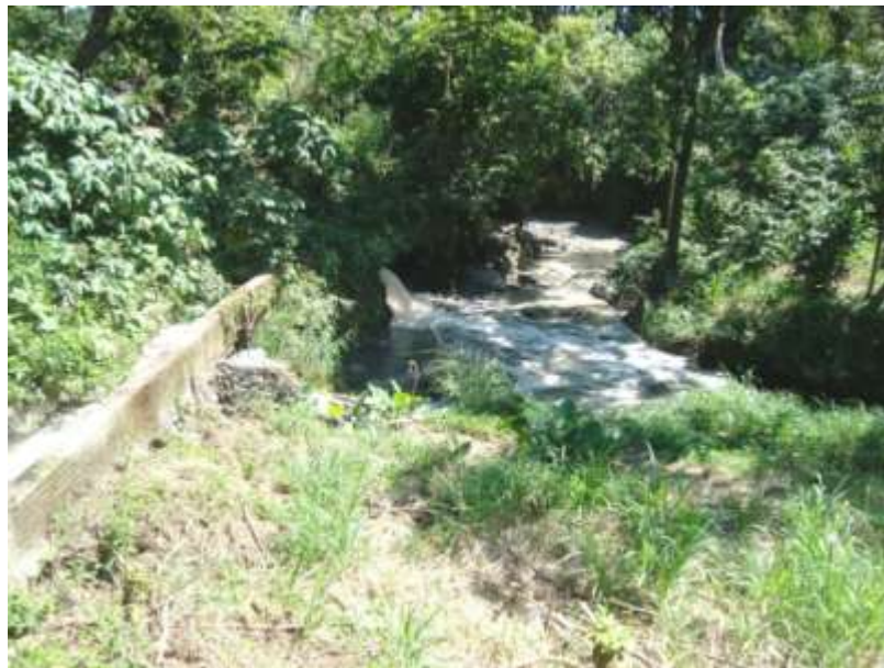
Foto 8. Punto donde se une el Rio con las aguas residuales en el cual se pretende implementar el diseño de la nueva etapa de la canaleta.
